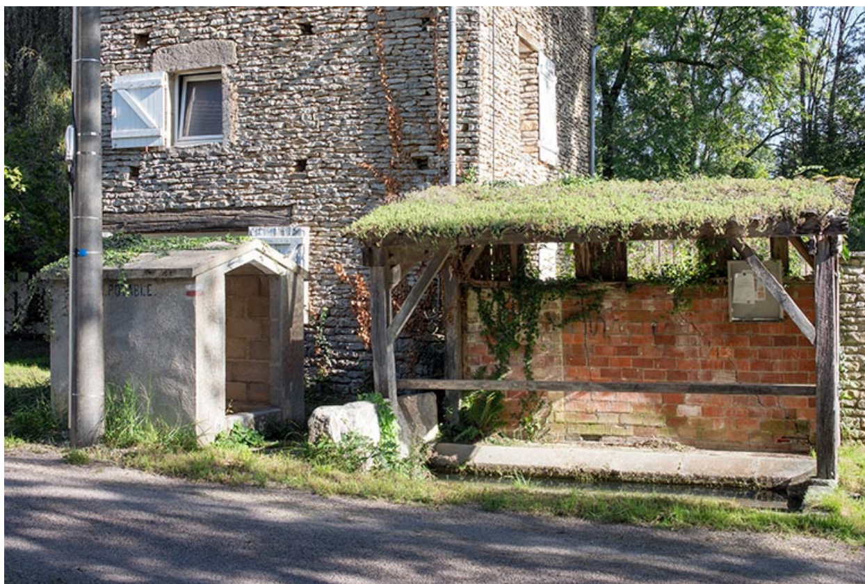
L'ensemble du lavoir et du puits.
