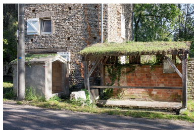
L'ensemble du lavoir et du puits. Phot. Nicolas Waltefaugle IVR26_20258900159NUC4A
