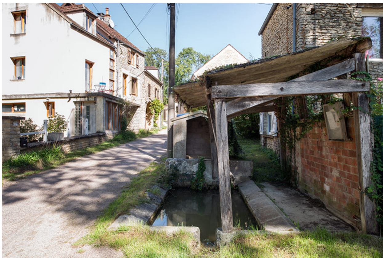
Le lavoir vu depuis l'ouest.
