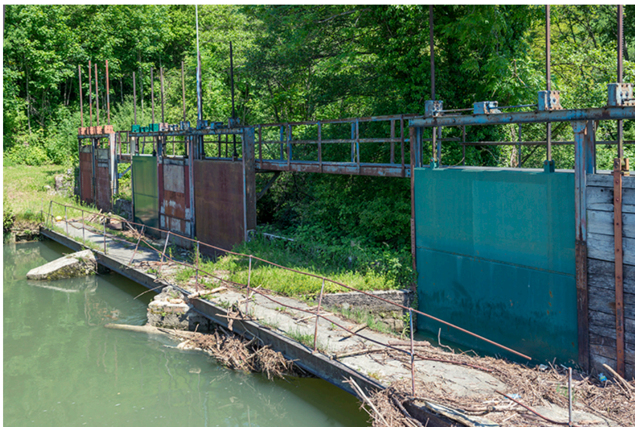
Vannage du canal.
