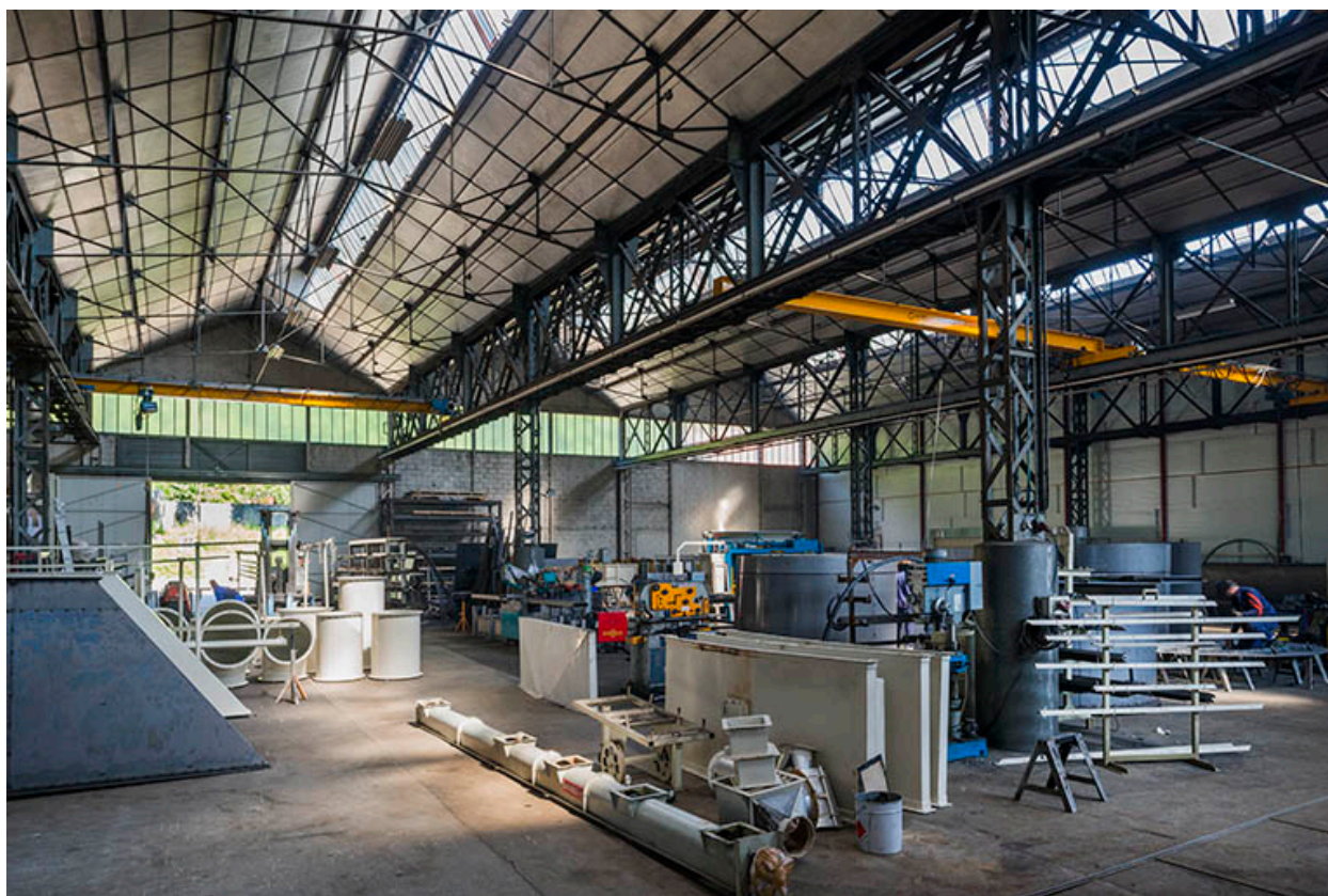
Vue intérieure de l'atelier de laminage.
