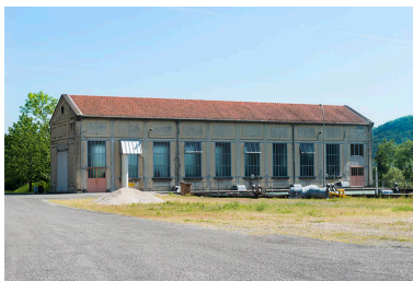
Façade sud de la centrale hydroélectrique. Phot. Mary Ruffinoni IVR43_20132500614NUC4A
