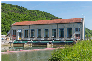
Bief d'amenée et centrale hydroélectrique. Phot. Mary Ruffinoni IVR43_20132500615NUC4A
