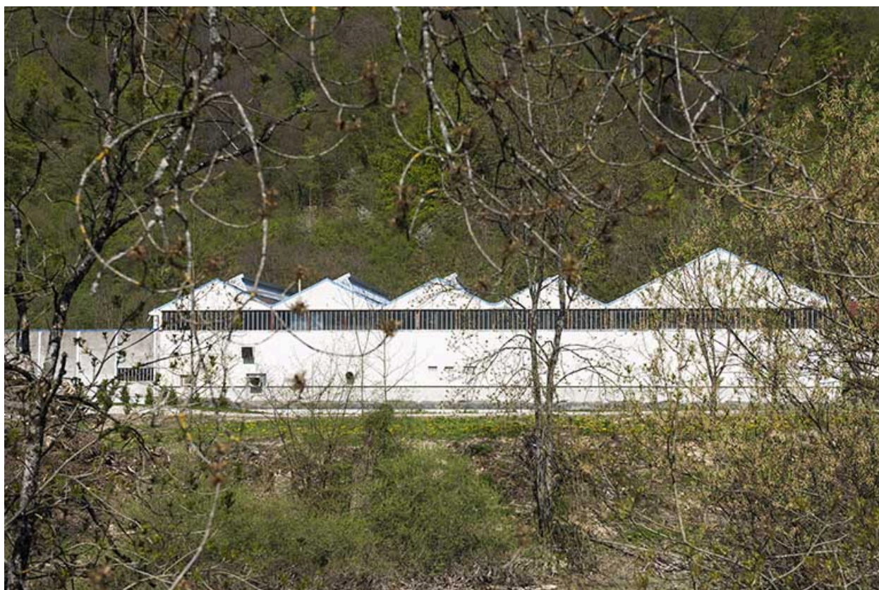
Façade est de l'atelier de laminage.
