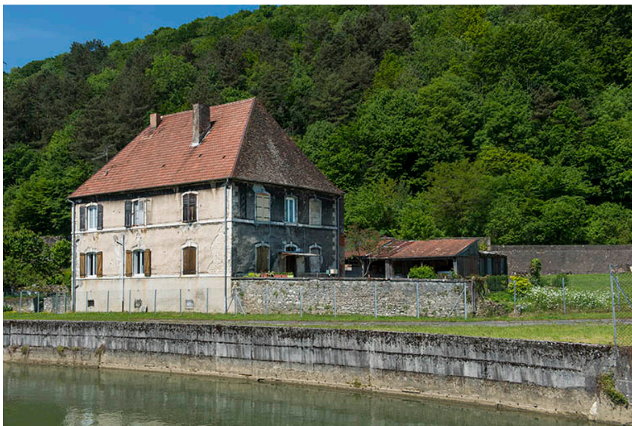
Bief d'amenée et logement patronal.
