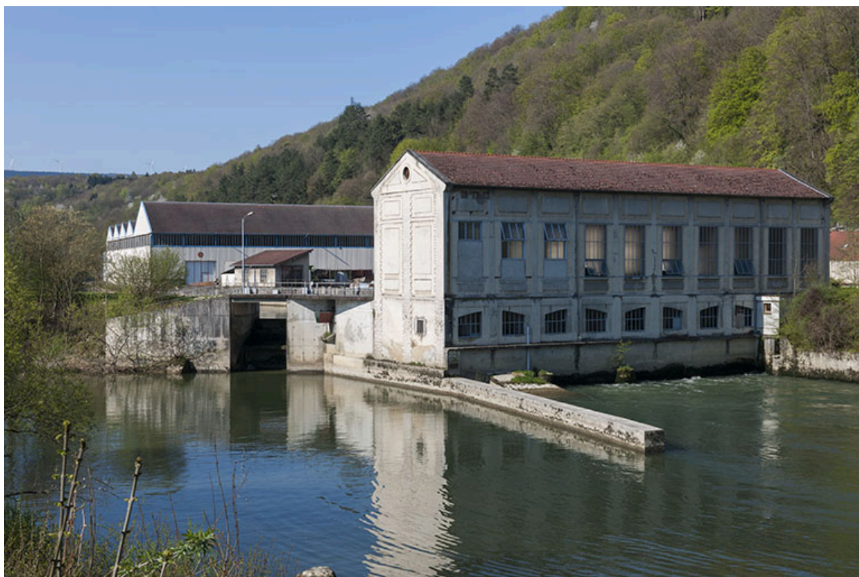
Vue d'ensemble du site depuis le nord-est.
