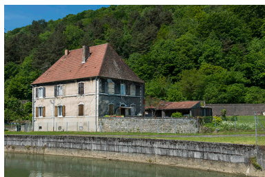
Bief d'amenée et logement patronal. Phot. Mary Ruffinoni IVR43_20132500634NUC4A
