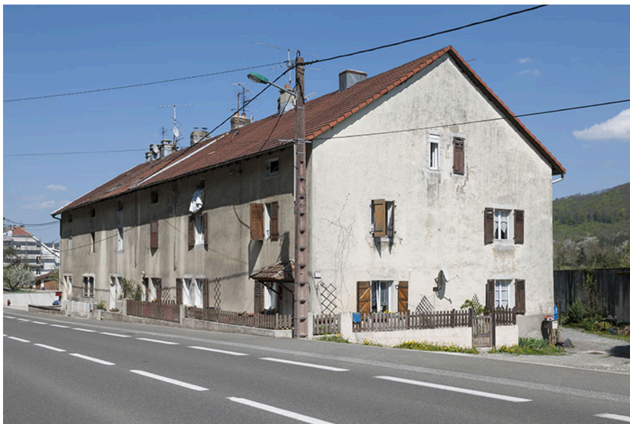
Logement d'ouvriers vu de trois quarts droite.
