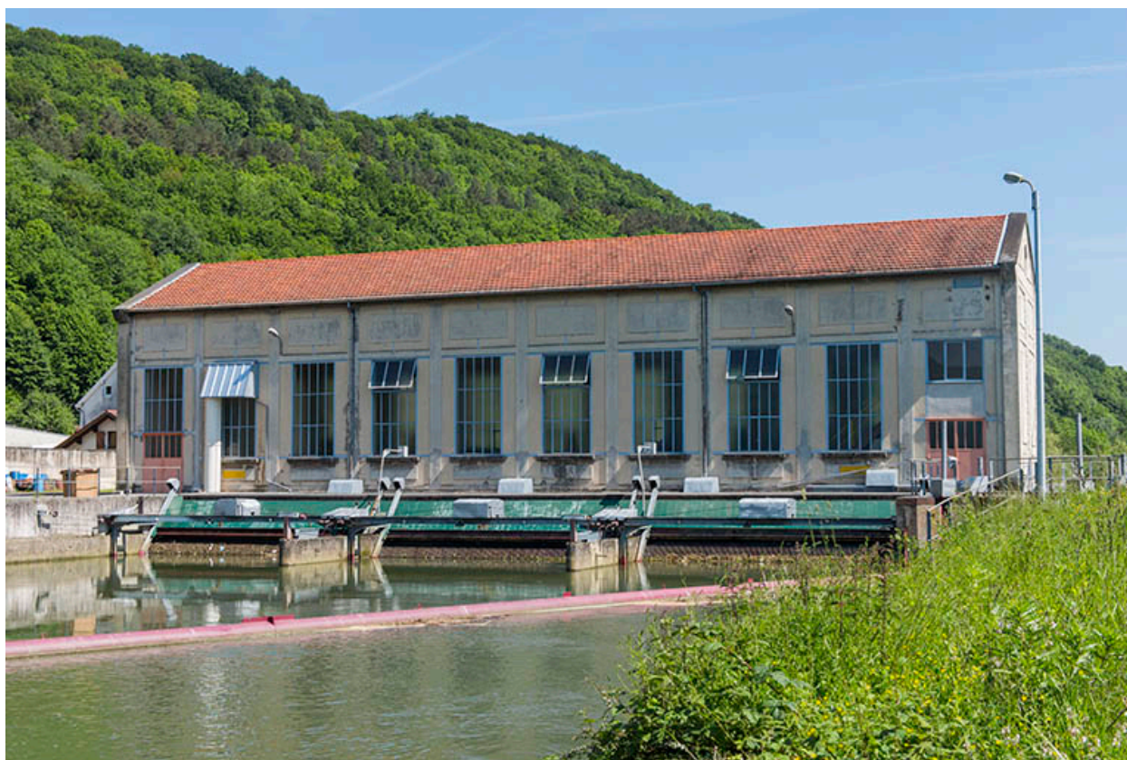
Bief d'amenée et centrale hydroélectrique.
