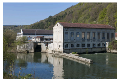
Vue d'ensemble du site depuis le nord-est.
