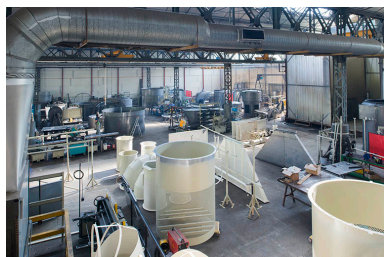
Vue plongeante sur l'atelier de laminage. Phot. Mary Ruffinoni IVR43_20132500613NUC4A
