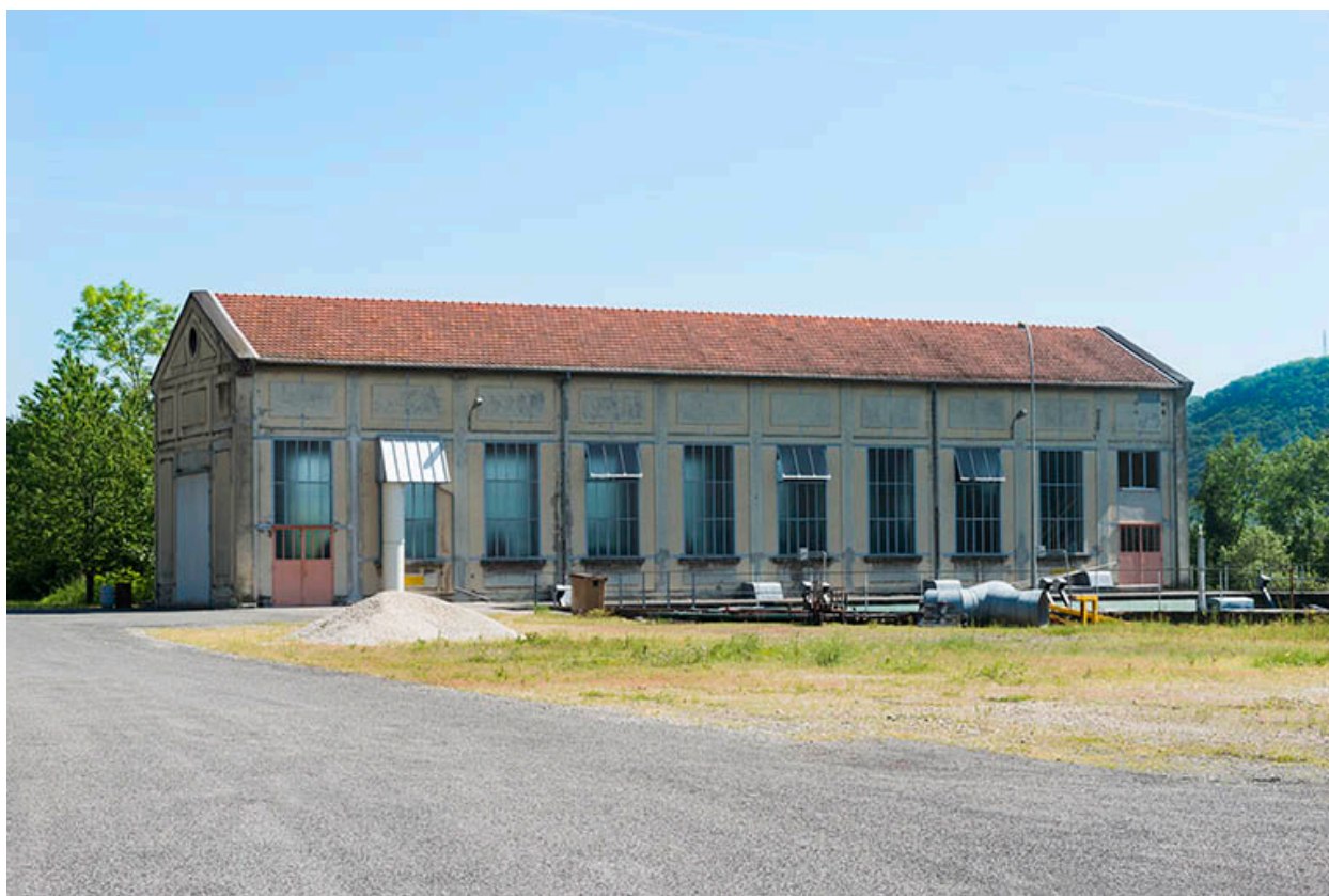
Façade sud de la centrale hydroélectrique.
