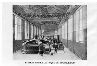
Station hydroélectrique de Bourguignon. Gravure, s.n., s.d. [vers 1923]. Phot. Raphaël Favereaux IVR43_20132500915NUC4A
