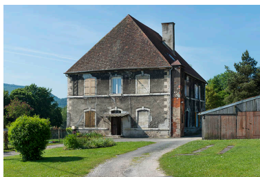
Façade nord du logement patronal. Phot. Mary Ruffinoni IVR43_20132500610NUC4A
