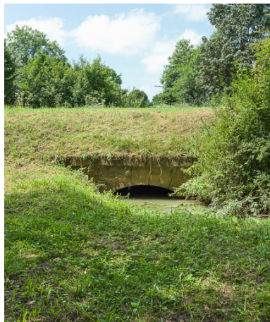
Vue de l'aqueduc. Phot. Pierre-Marie Barbe-Richaud IVR26_20175800133NUC2A
