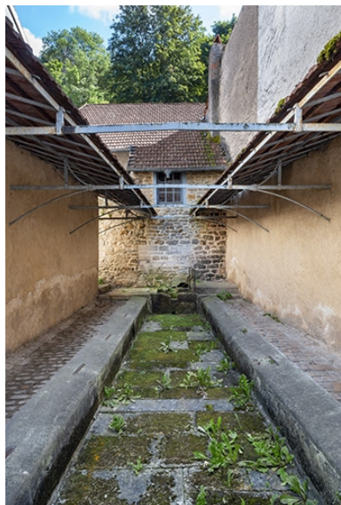
L'intérieur de la fontaine-lavoir.
