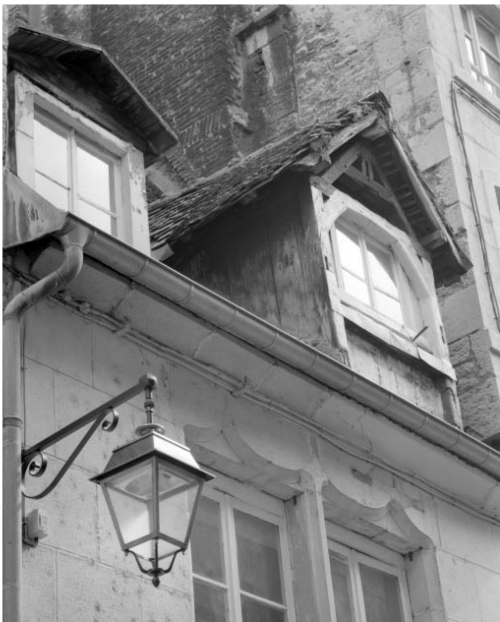
Façade sur rue : détail des lucarnes.
