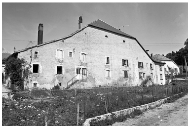
Ferme située route de La Planée à Oye-et-Pallet. Phot. Dominique Dominguez IVR43_19792500996X
