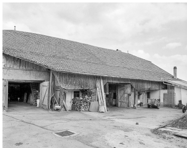
Mur goutterot d'une ferme. Phot. Dominique Dominguez IVR43_19792500992X
