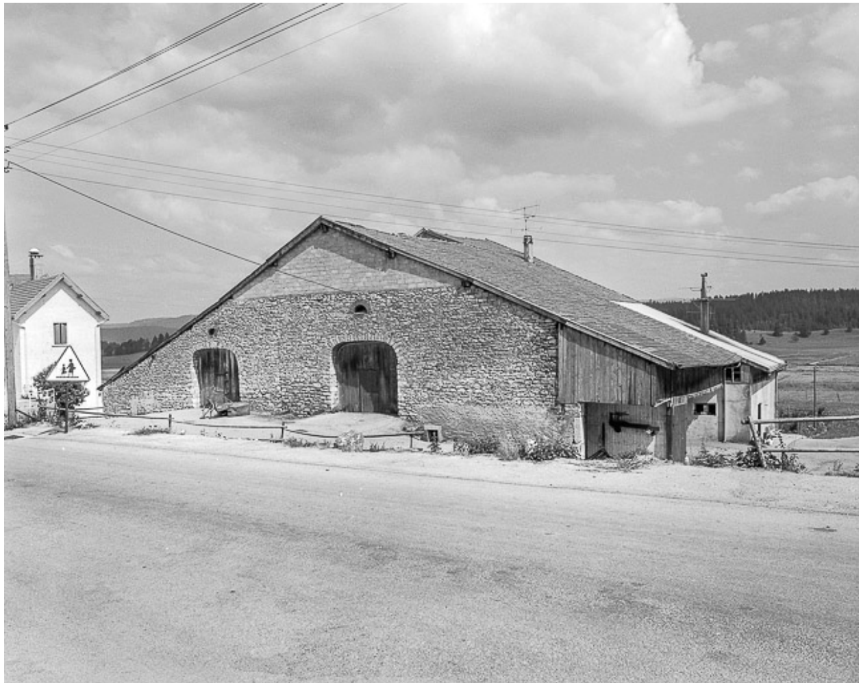
Pignon sur rue et mur goutterot d'une ferme.
