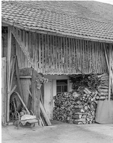
Galerie en bois sous le débord d'un toit de ferme. Phot. Dominique Dominguez IVR43_19792500993X
