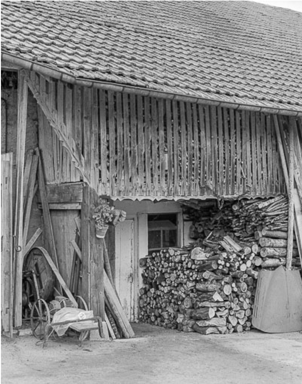
Galerie en bois sous le débord d'un toit de ferme.
