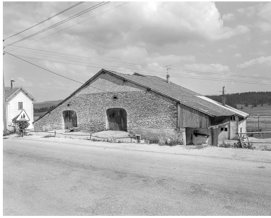
Pignon sur rue et mur goutterot d'une ferme. Phot. Dominique Dominguez IVR43_19792500990X
