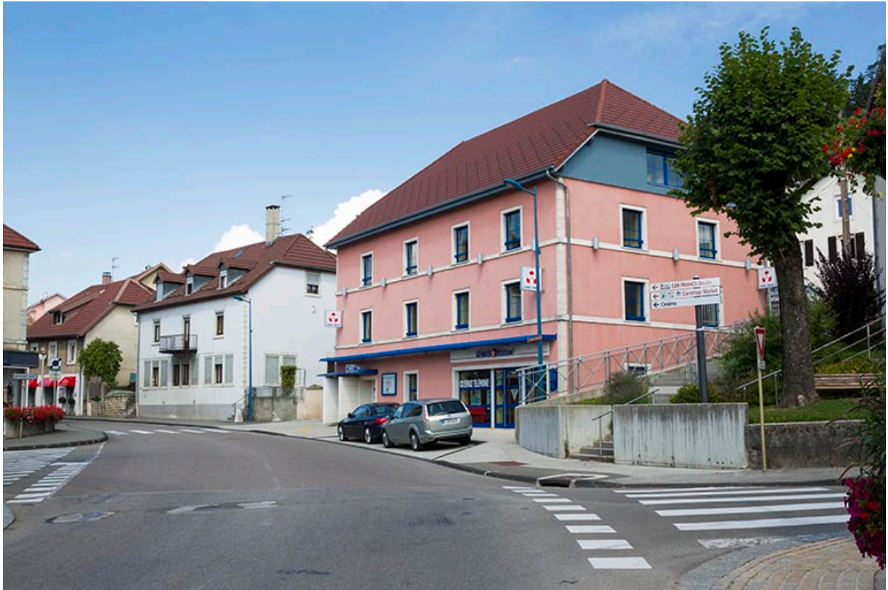
Vue d'ensemble, depuis le sud.
