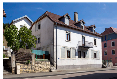
Façades antérieure et latérale gauche. Phot. Yves Sancey IVR43_20132501990NUC2A
