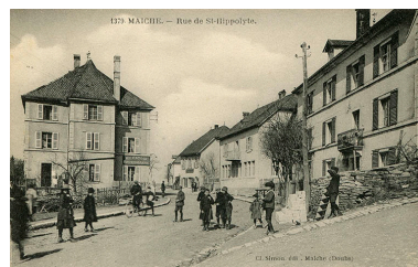
1379. Maïche - Rue de St-Hippolyte, 1ère moitié 20e siècle. Après percement des fenêtres multiples. Autr. Charles Simon IVR43_20152502038NUC4A
