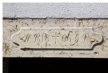
Façade latérale droite : linteau daté 1866. Phot. Yves Sancey IVR43_20132501988NUC2A
