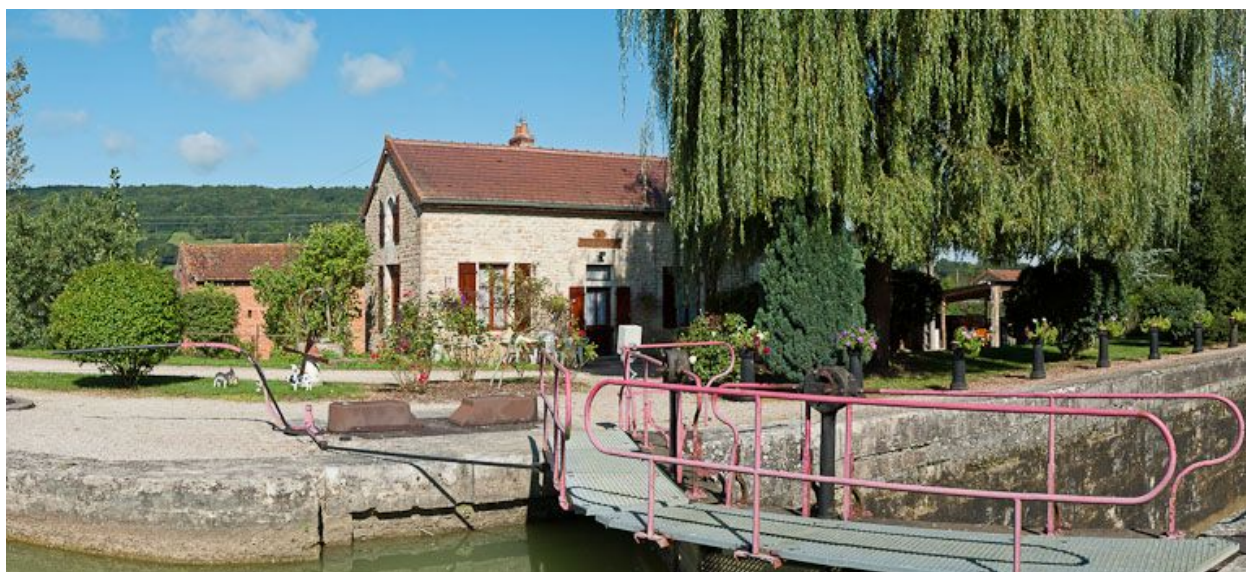
Vue du site d'écluse depuis l'amont.
