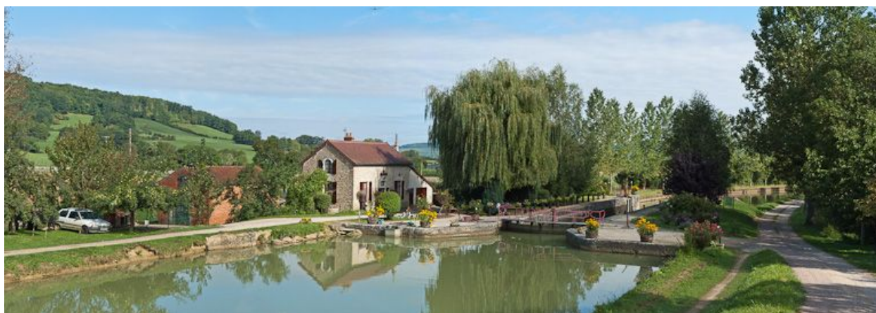
Vue du site d'écluse depuis l'amont.
