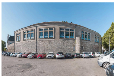
Vue générale. Phot. Thierry Kuntz IVR26_20247100031NUC4A
