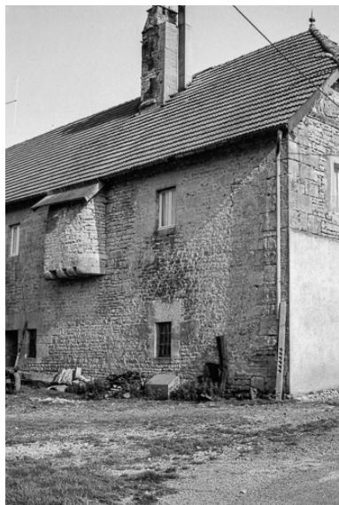
Partie droite de la façade postérieure avec le cul-du- four extérieur suspendu. Phot. Gilbert Poinot IVR43_19752501397Z
