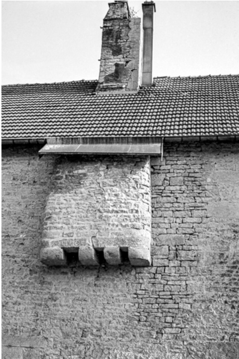
Façade postérieure : cul-du-four extérieur suspendu.
