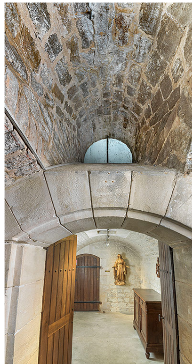
Puits de lumière avant l'accès au vestibule. Phot. Thierry Kuntz IVR26_20252100420NUC4A
