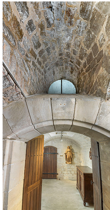
Puits de lumière avant l'accès au vestibule.
