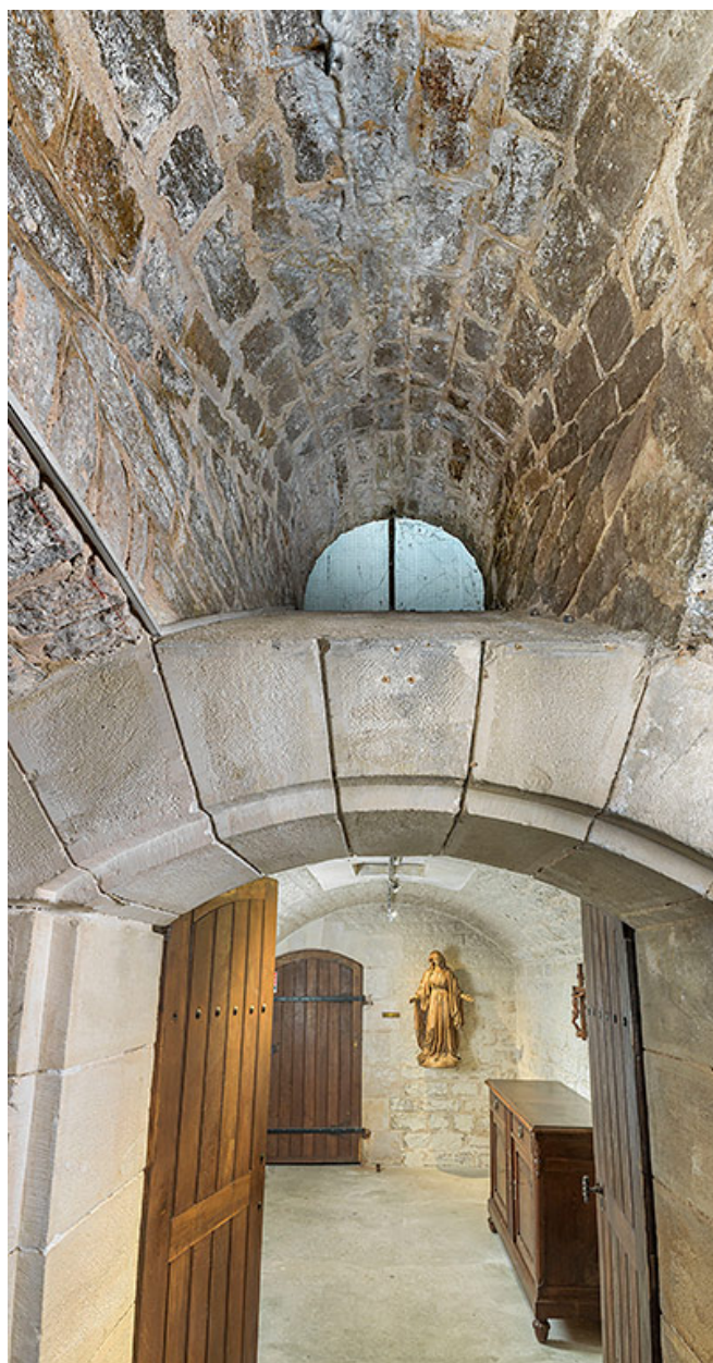
Puits de lumière avant l'accès au vestibule.
