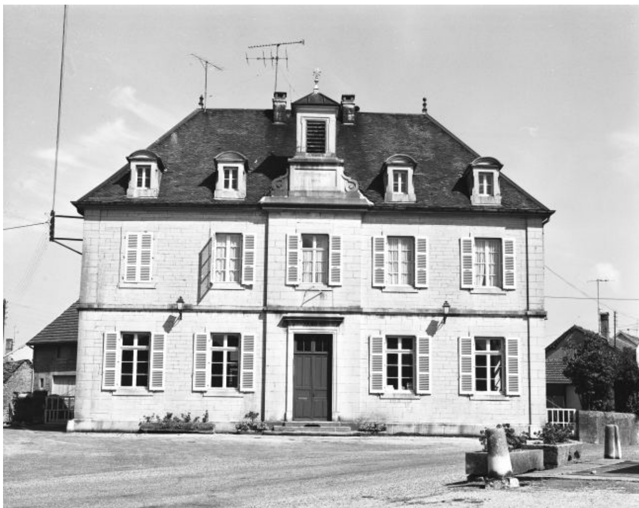
Façade antérieure : vue rapprochée.
