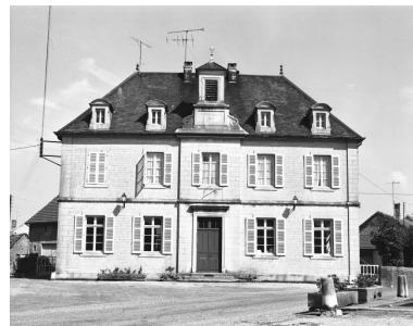
Façade antérieure : vue rapprochée. Phot. Yves Sancey IVR43_19793900100X
