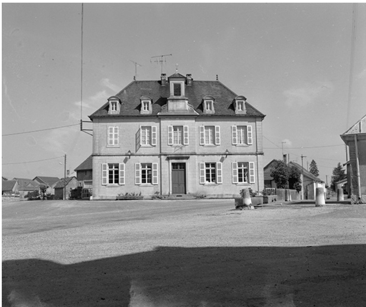
Façade antérieure vue depuis la rue.
