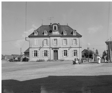
Façade antérieure vue depuis la rue. Phot. Yves Sancey IVR43_19793900099X
