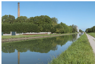
La cheminée de l'usine.
