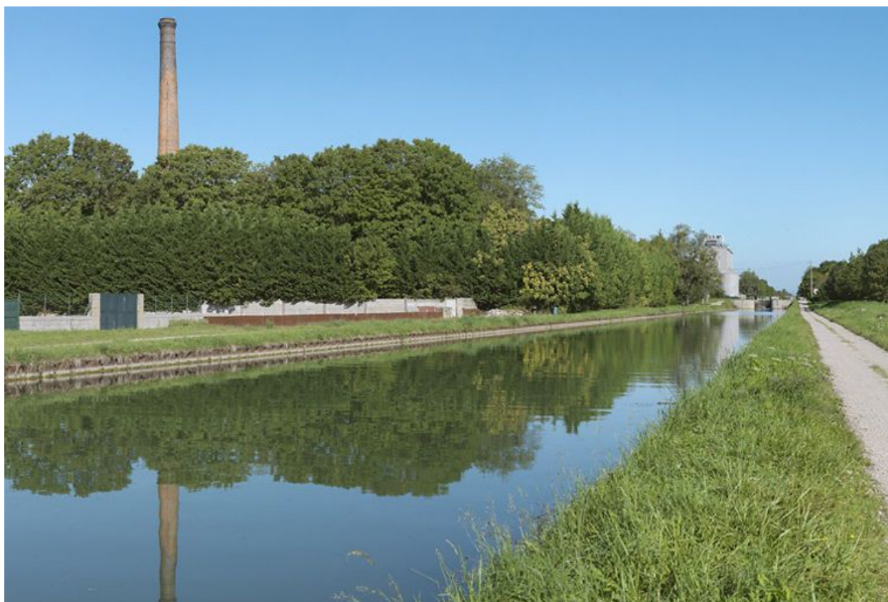
La cheminée de l'usine.
