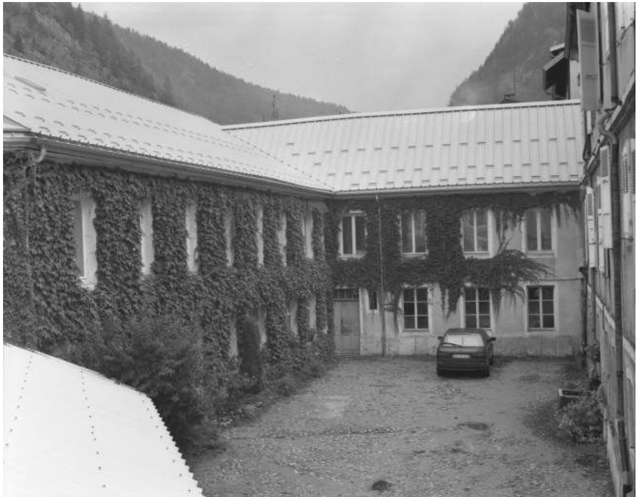
Façades de l'usine sur la cour.
