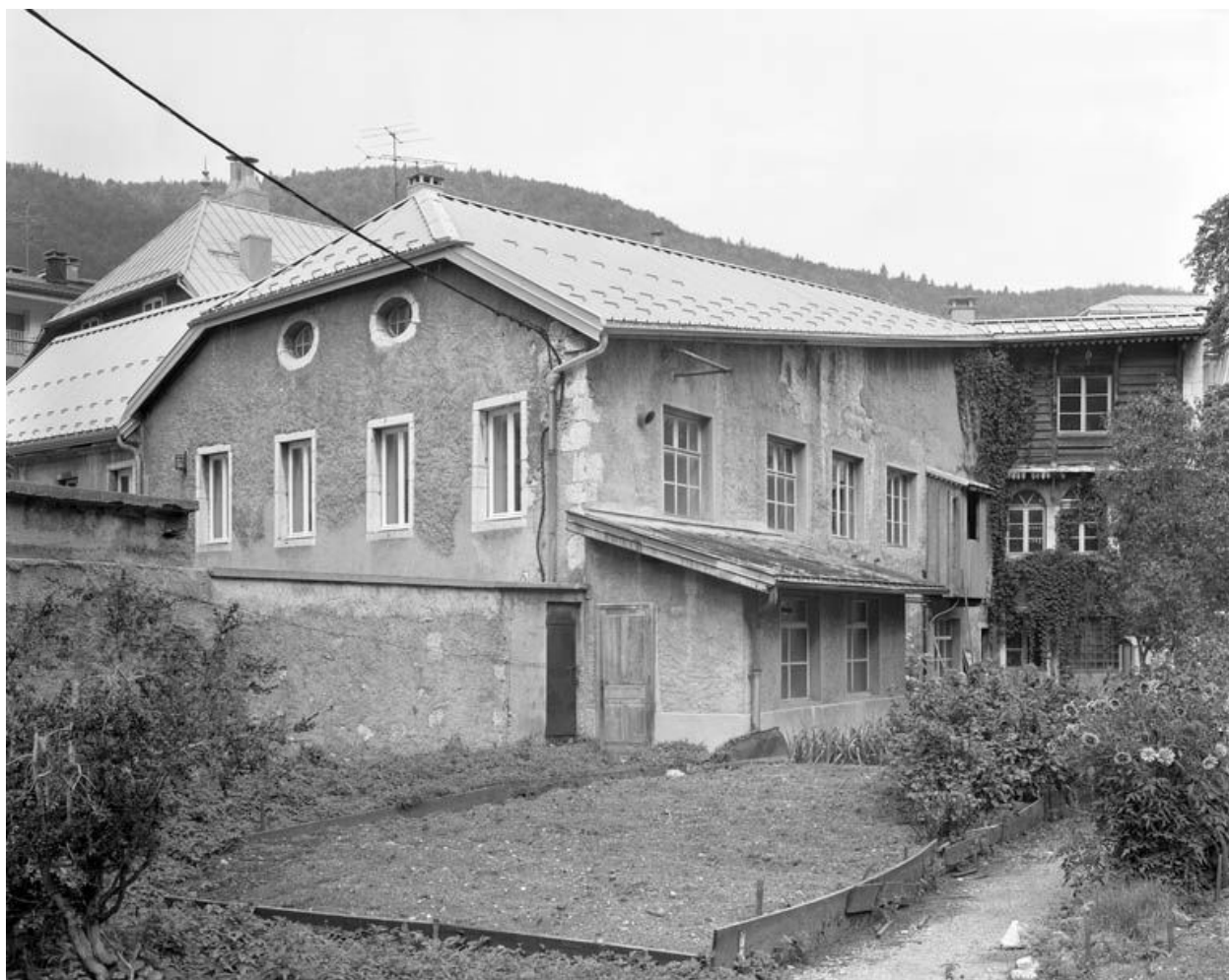
Façades latérale droite et postérieure de l'usine.
