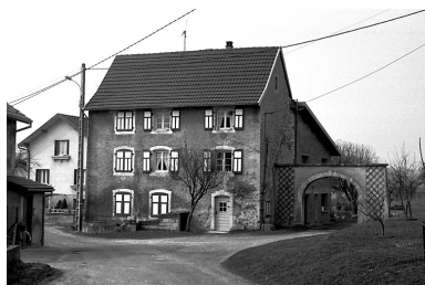
Vue d'ensemble. Phot. Bernard Lardière IVR43_19832500360Z
