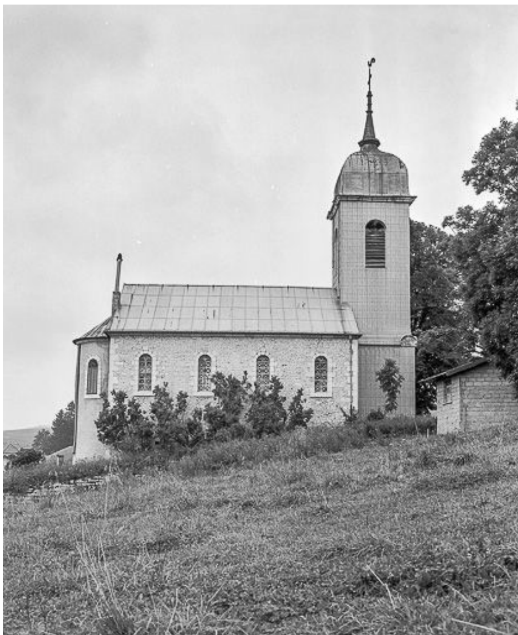
Façade latérale droite.
