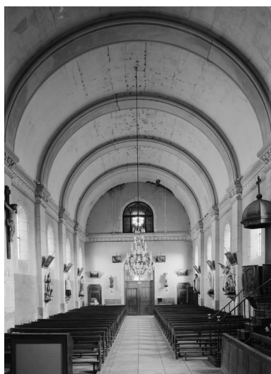
Vue de la nef depuis le chœur.
