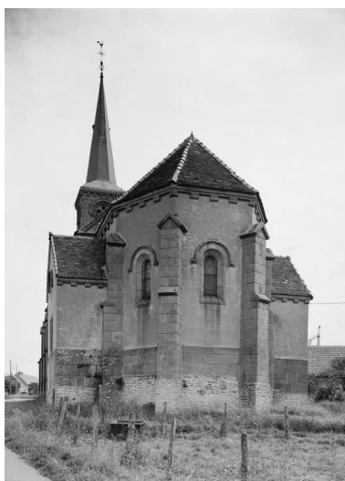
Vue du chevet. Phot. Michel Thierry IVR26_19782101166V
