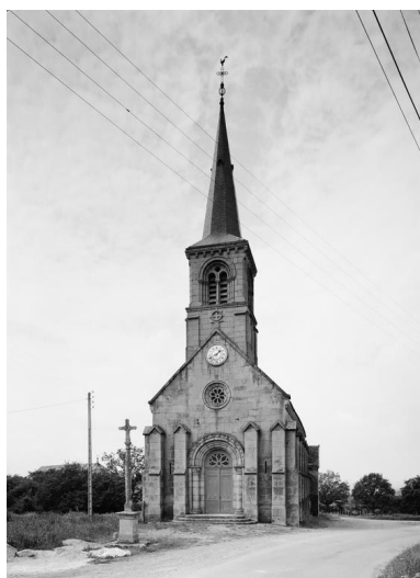
Vue de la façade. Phot. Michel Thierry IVR26_19782101164V
