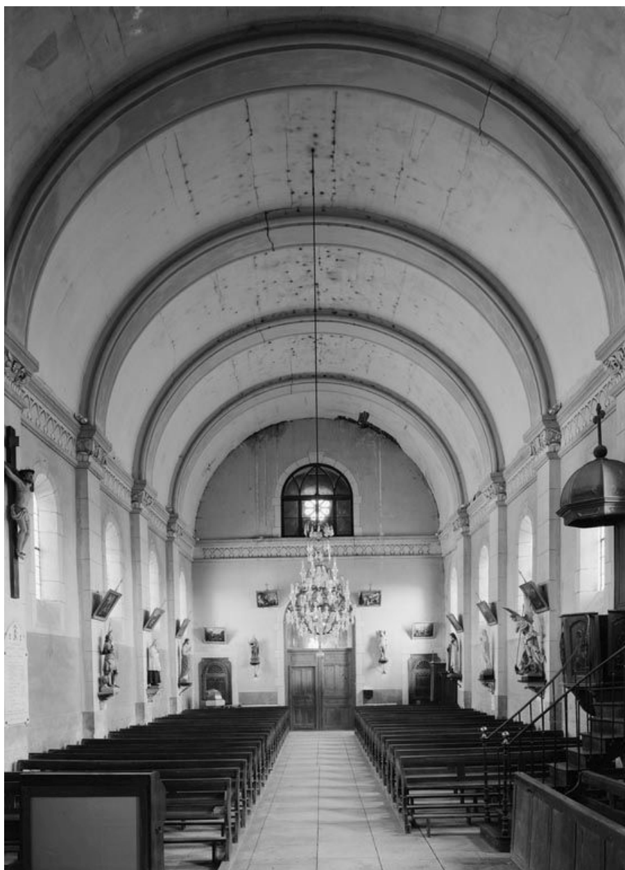
Vue de la nef depuis le chœur.
