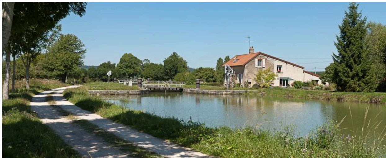
Vue d'ensemble du site d'écluse.
