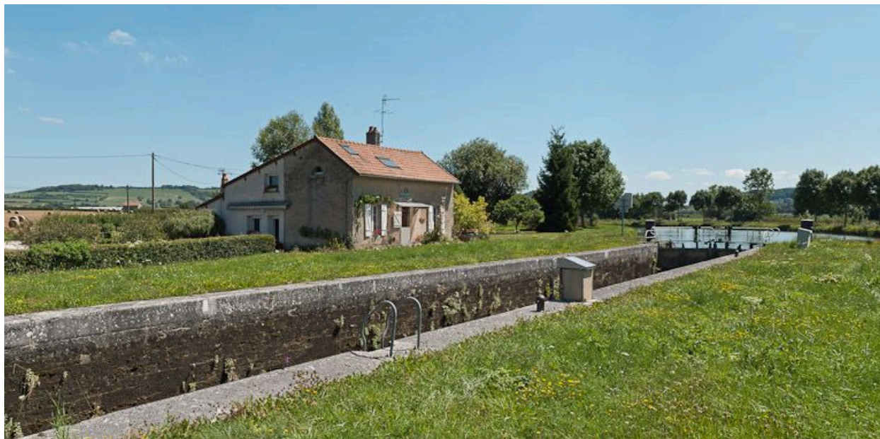
Vue d'ensemble du site d'écluse.
