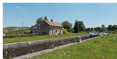
Vue d'ensemble du site d'écluse. Phot. Pierre-Marie Barbe-Richaud IVR26_20112103706NUC4AQ
