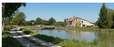
Vue d'ensemble du site d'écluse. Phot. Pierre-Marie Barbe-Richaud IVR26_20112103700NUC4AQ
