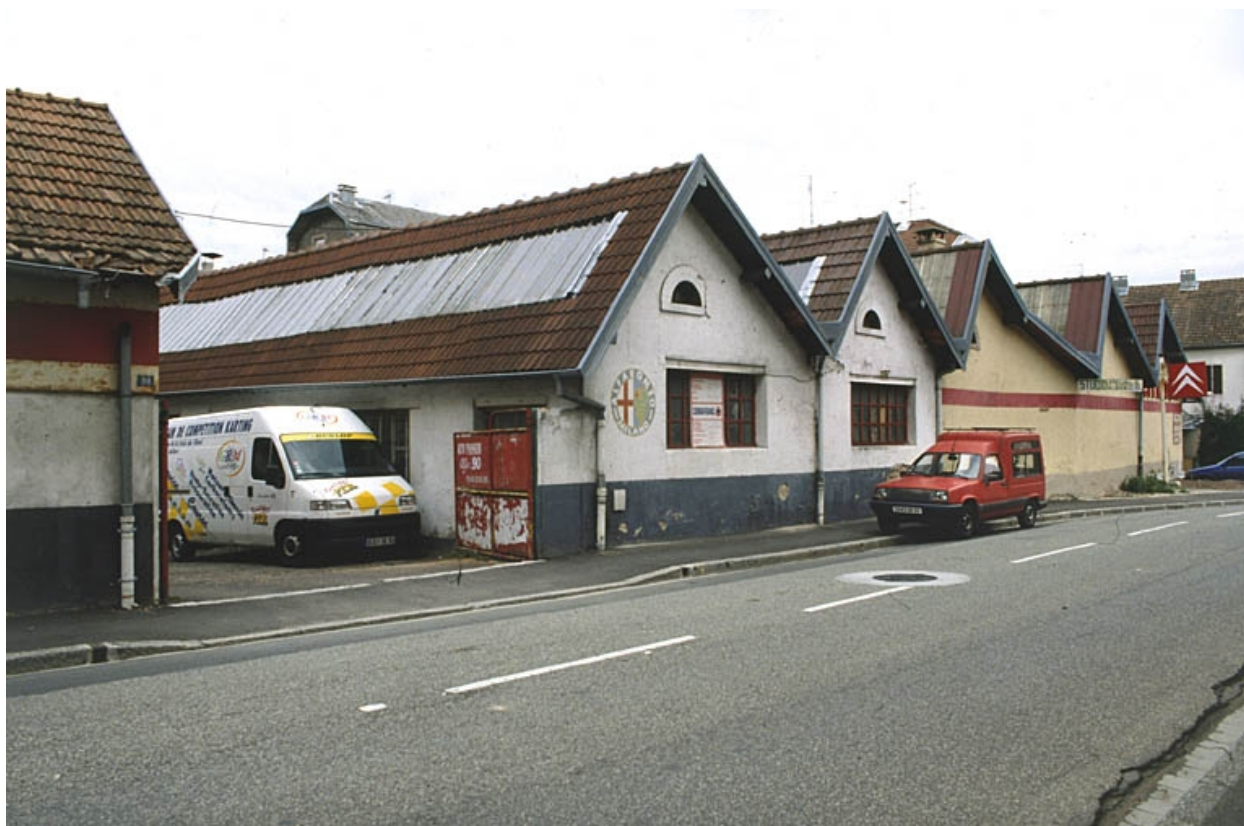
Pignons des ateliers depuis le nord-ouest.
