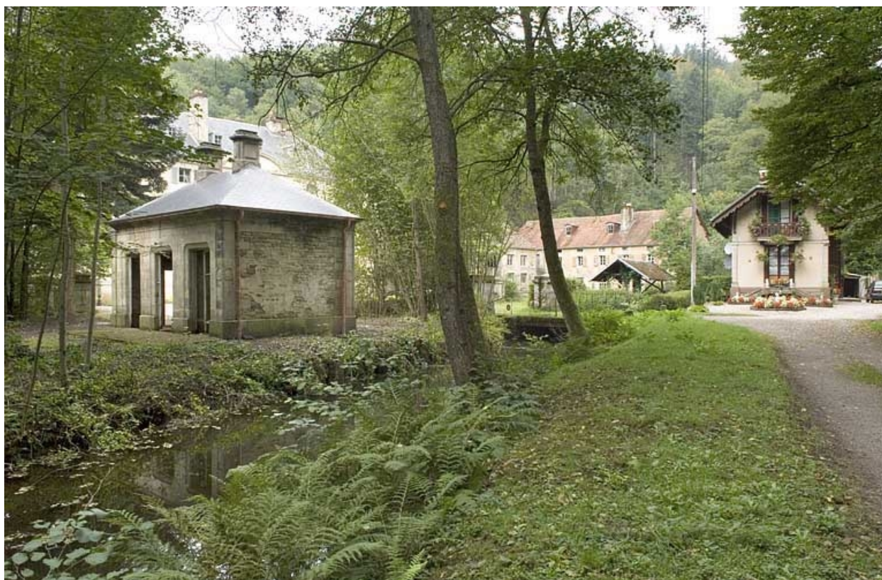
Vue d'ensemble depuis l'allée d'entrée.
