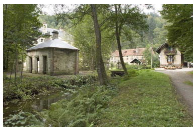
Vue d'ensemble depuis l'allée d'entrée. Phot. Jérôme Mongreville IVR43_20067000710NUCA
