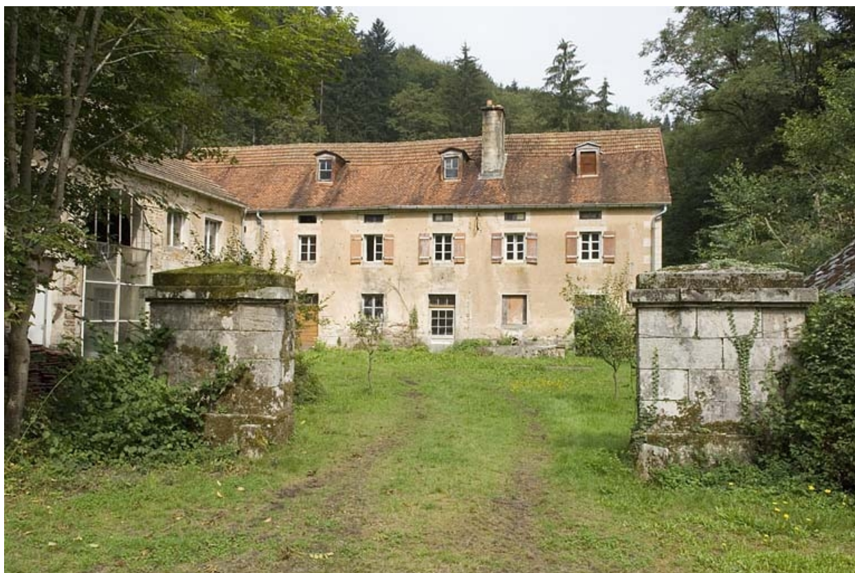
Logement de la ferme.
