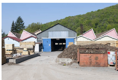
Pignons est des ateliers de fabrication. Phot. Jérôme Mongreville IVR43_20112501634NUC4A
