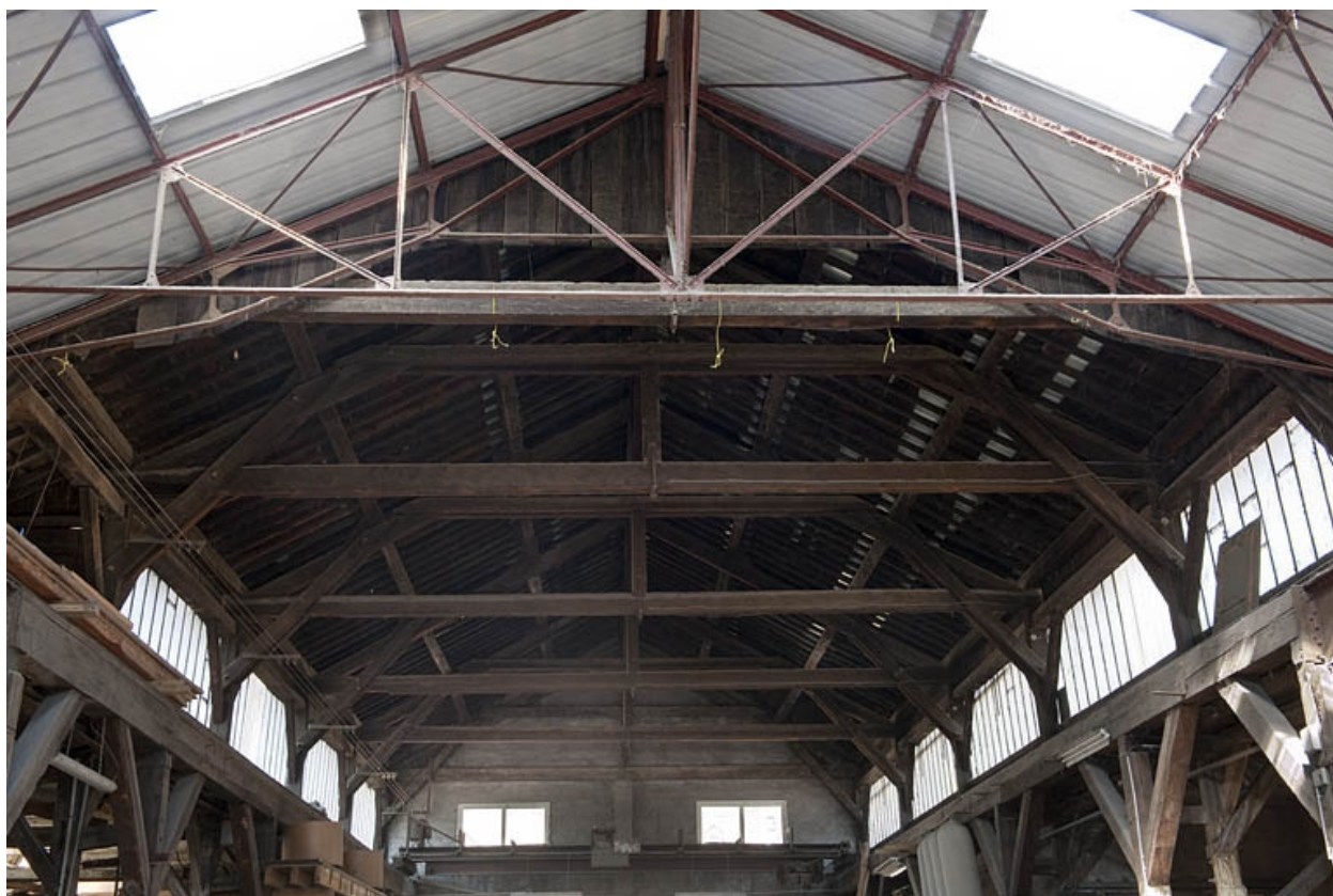
Halle de fonderie. La charpente.
