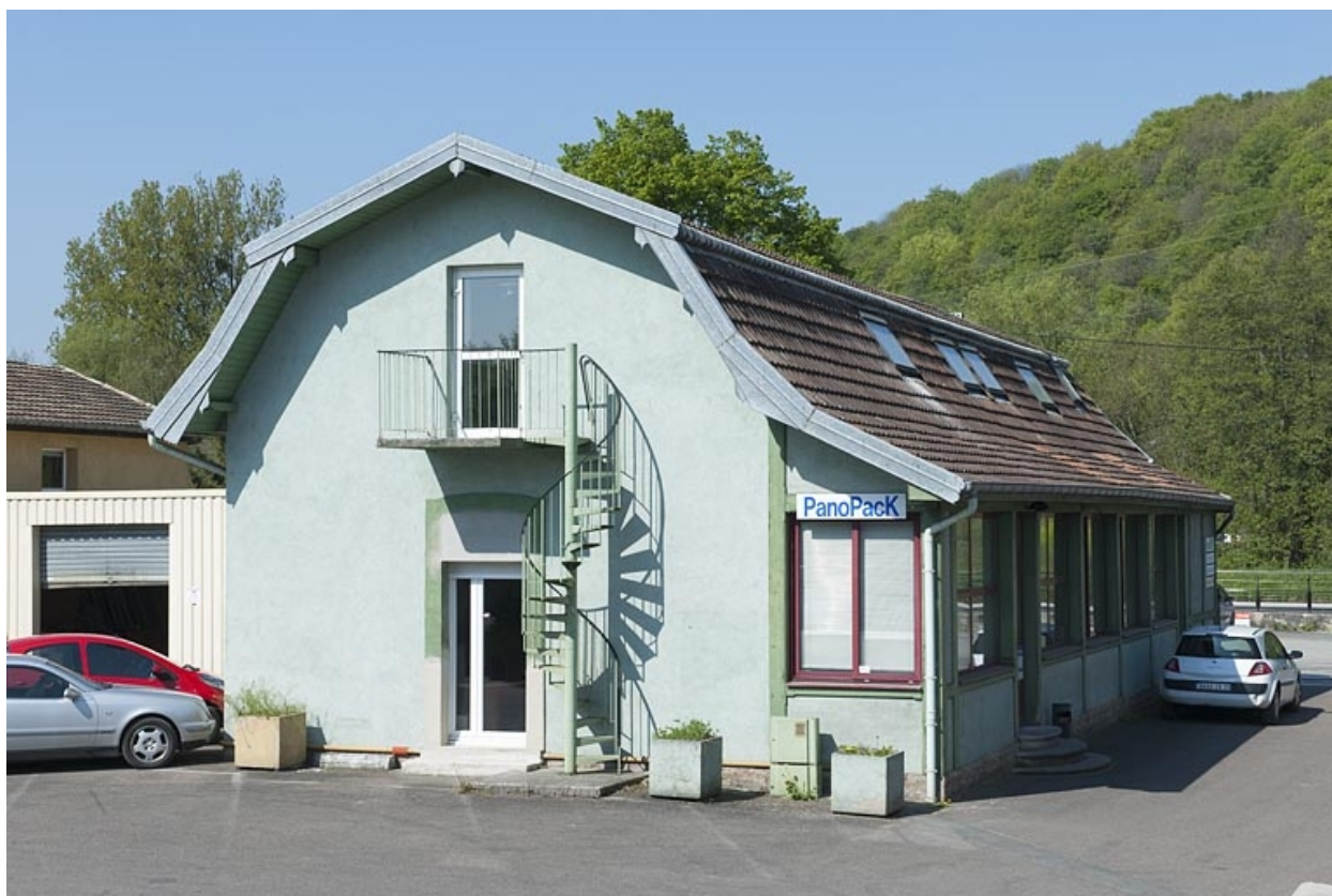
Bureaux. Vue depuis le nord-est.
