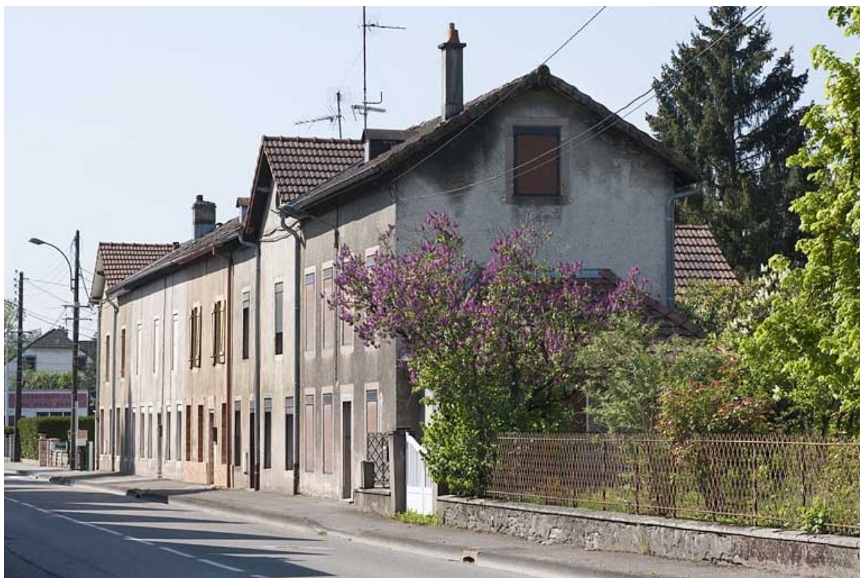
Logements ouvriers. Vue de trois quarts droite.
