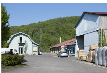
Vue d'ensemble depuis la cour, vers l'est. Phot. Jérôme Mongreville IVR43_20112501630NUC4A
