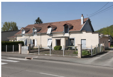
Logements ouvriers. Phot. Jérôme Mongreville IVR43_20112501650NUC4A
