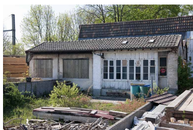
Bâtiment industriel (?). Phot. Jérôme Mongreville IVR43_20112501633NUC4A
