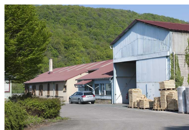
Magasins industriels à l'entrée du site. Phot. Jérôme Mongreville IVR43_20112501632NUC4A
