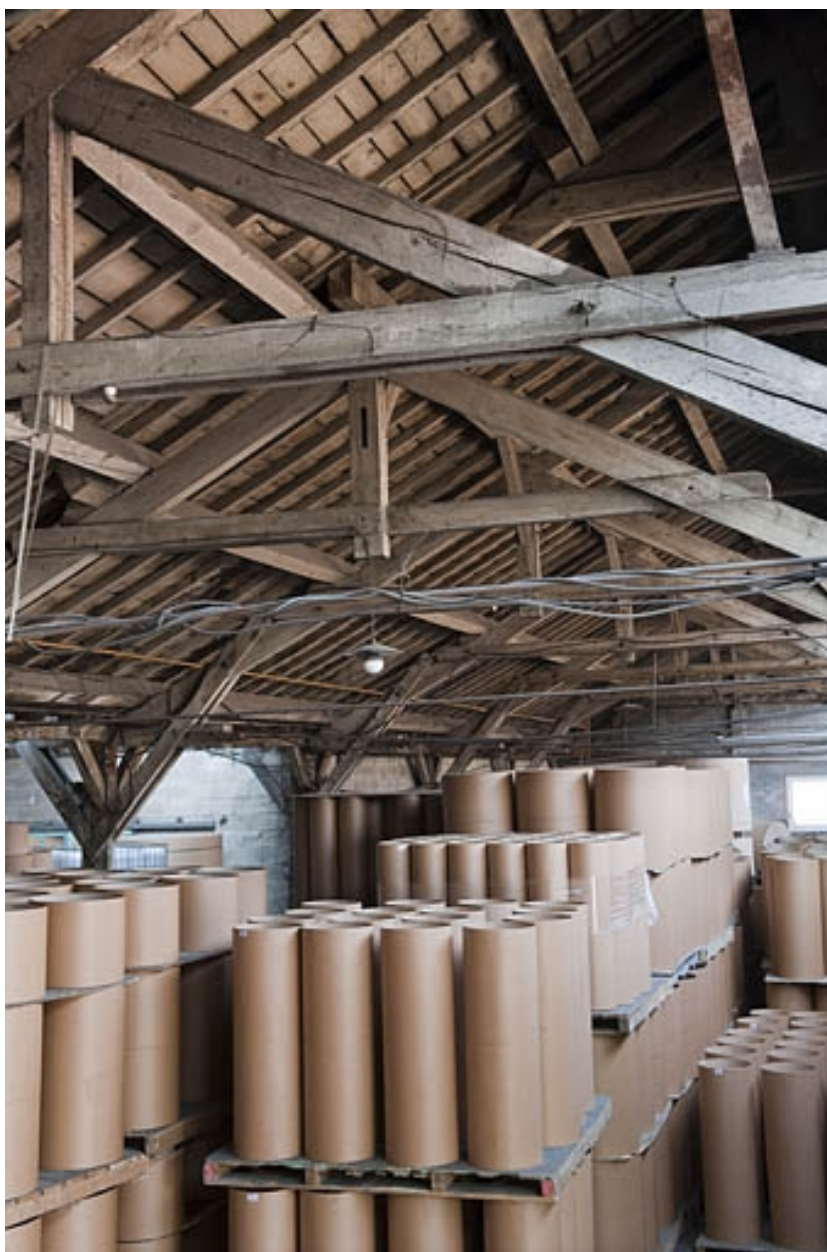
La charpente du magasin industriel (cadrage vertical).
