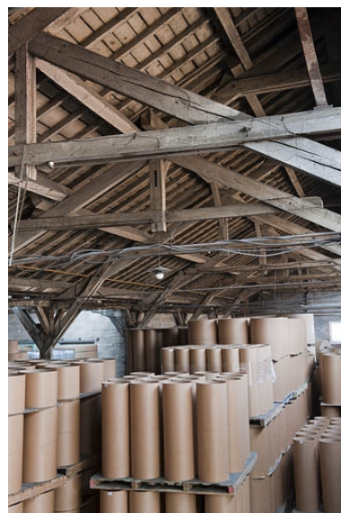
La charpente du magasin industriel (cadrage vertical). Phot. Jérôme Mongreville IVR43_20112501641NUC4A
