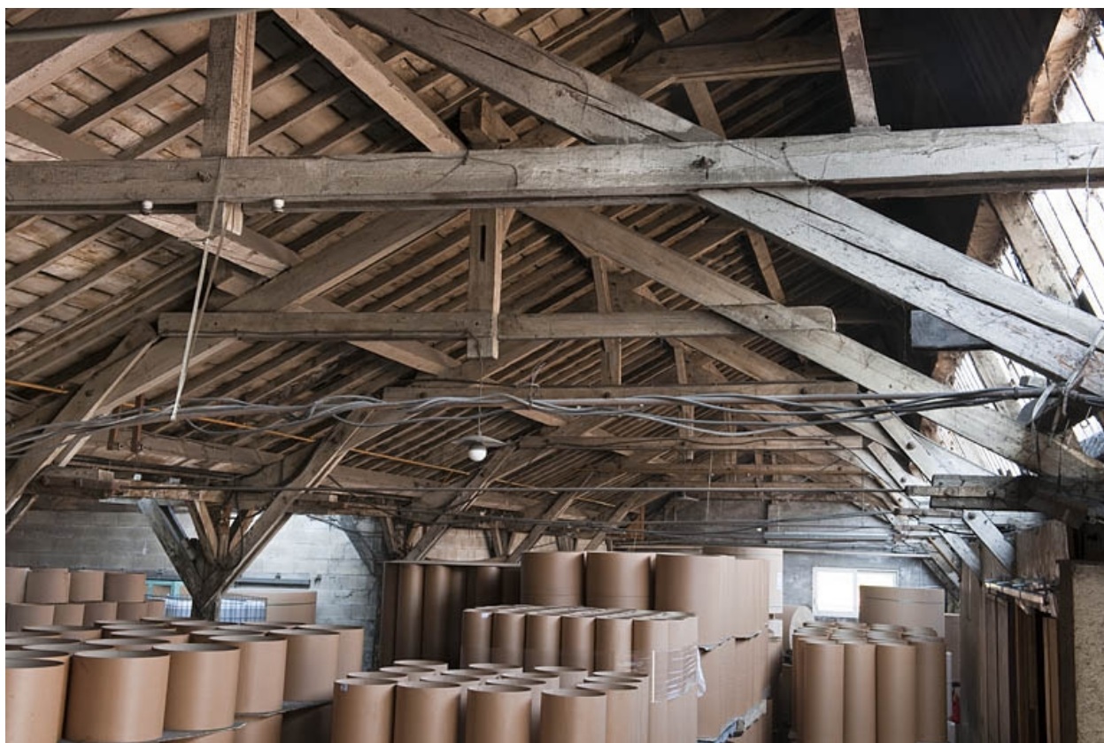
Magasin industriel. Détail de la charpente en bois.
