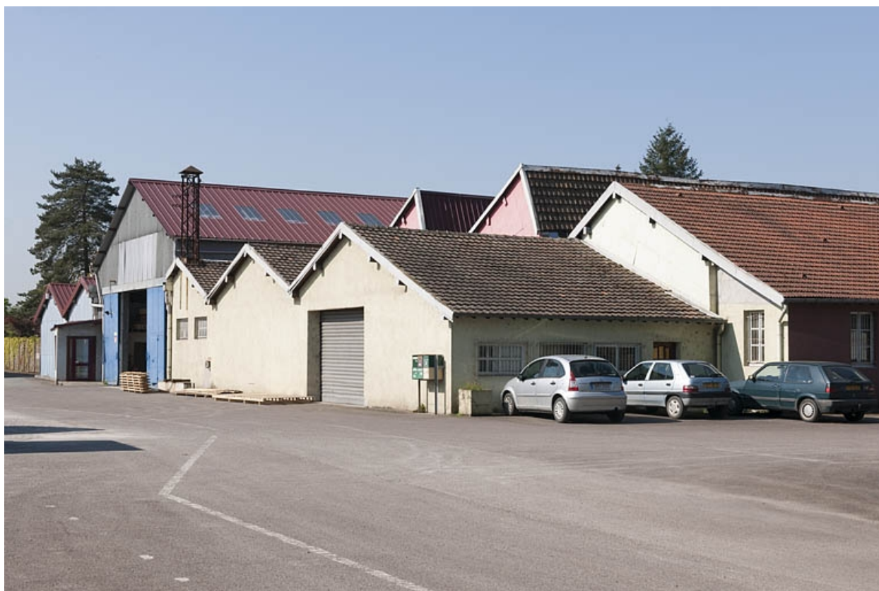
Bâtiments industriels vus depuis le nord-est.
