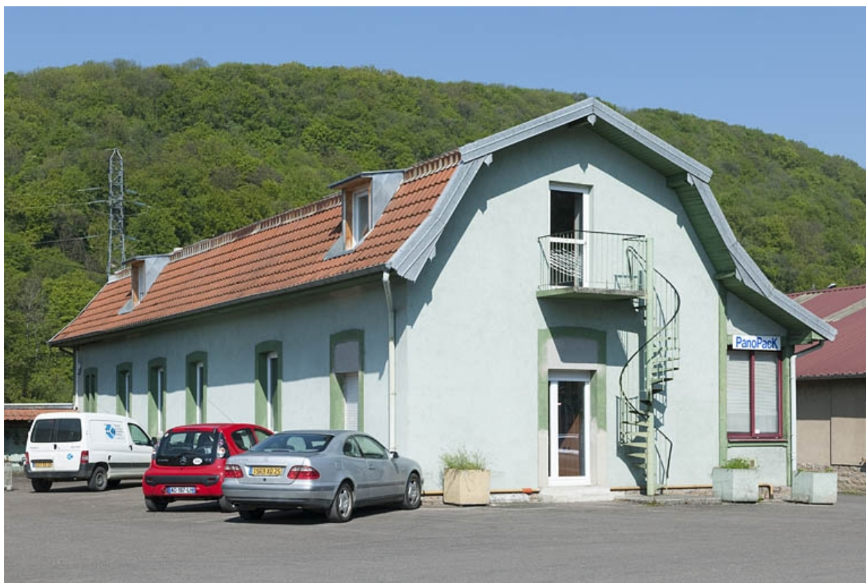
Bureaux. Vue depuis le sud-est.
