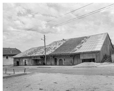
Fermes situées Grande Rue. Phot. Dominique Dominguez IVR43_19792501043X
