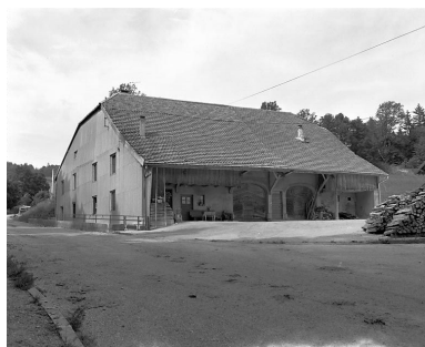
Ferme située chemin des Esseux. Phot. Yves Sancey IVR43_19782500516X
