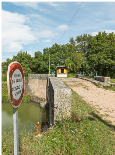
Vue du pont.
