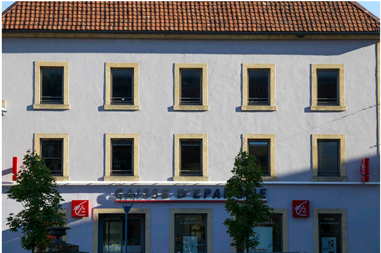
Façade antérieure : fenêtres des deux étages carrés.
