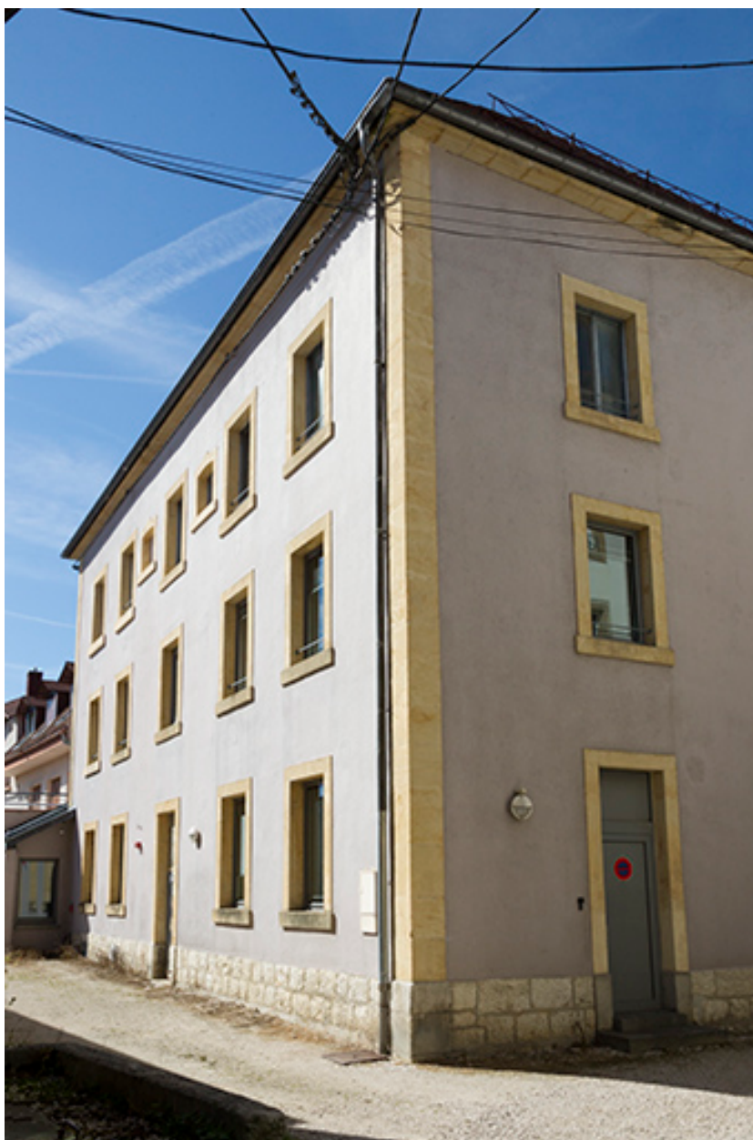
Façade postérieure, vue en enfilade.
