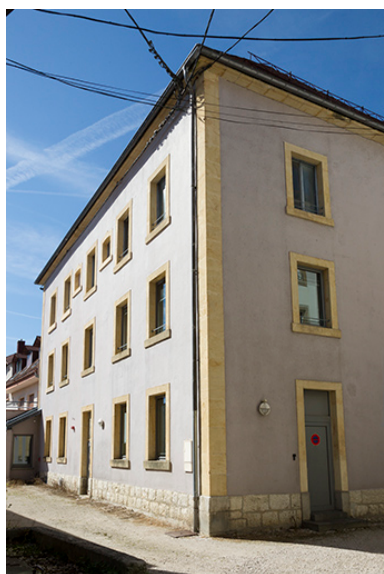
Façade postérieure, vue en enfilade.
