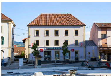
Façade antérieure (2013). Phot. Yves Sancey IVR43_20132502266NUC2A
