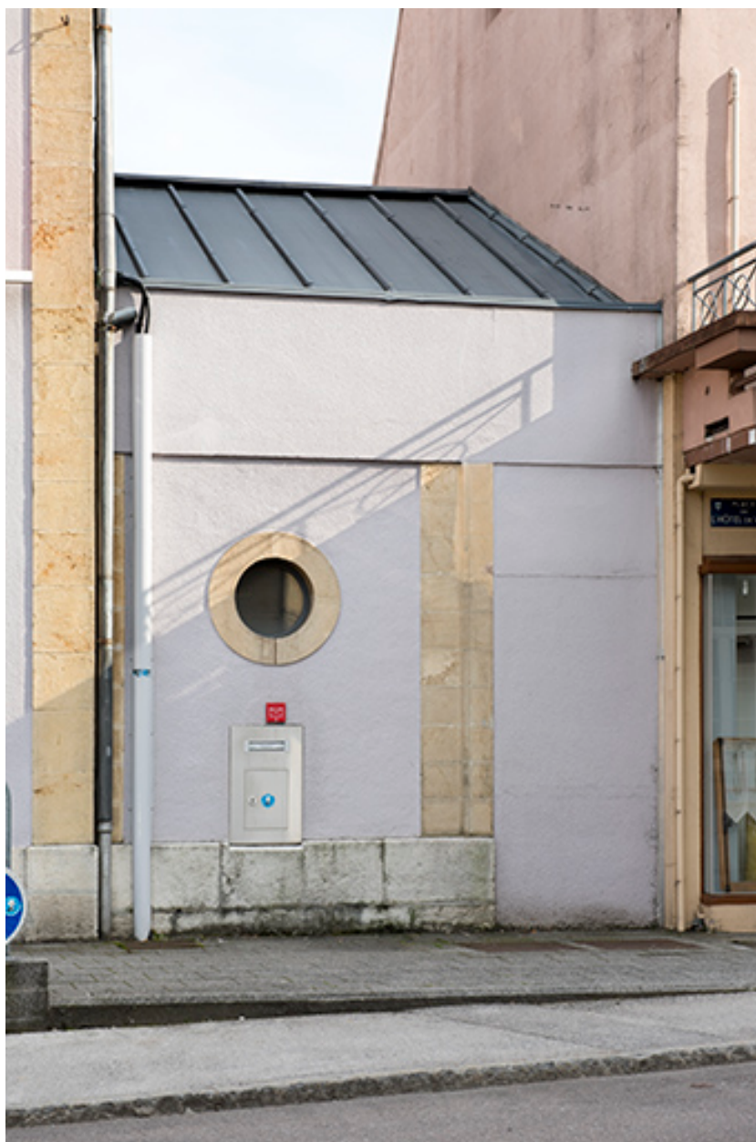
Façade antérieure : vestige de l'atelier de fabrication.
