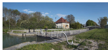
Vue d'amont. Phot. Thierry Kuntz IVR26_20112102602NUC4A
