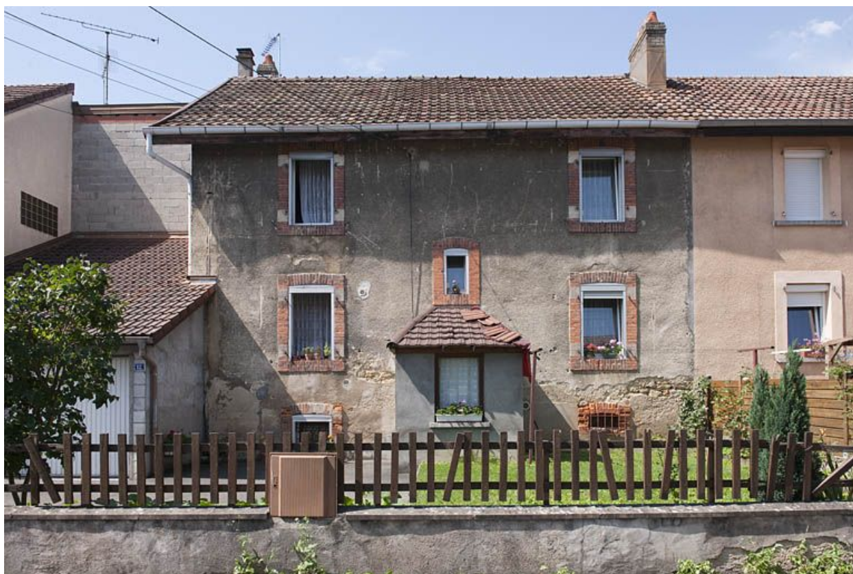
Façade antérieure vue de face.
