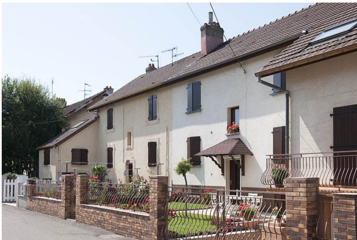
Habitation vue de trois quarts droite.
