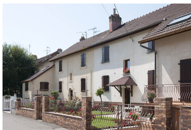
Habitation vue de trois quarts droite. Phot. Jérôme Mongreville IVR43_20112502082NUC4A
