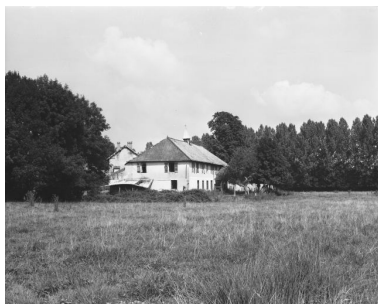
Ferme située rue du Bief. Phot. Dominique Dominguez IVR43_19803900288X
