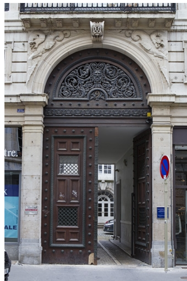
Portail d'entrée : vue d'ensemble.
