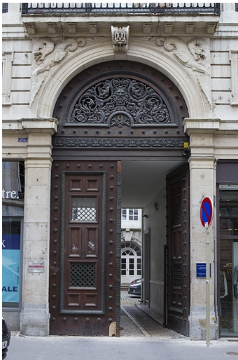
Portail d'entrée : vue d'ensemble.
