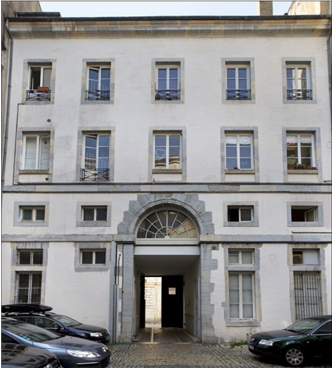
Façade postérieure, de face.
