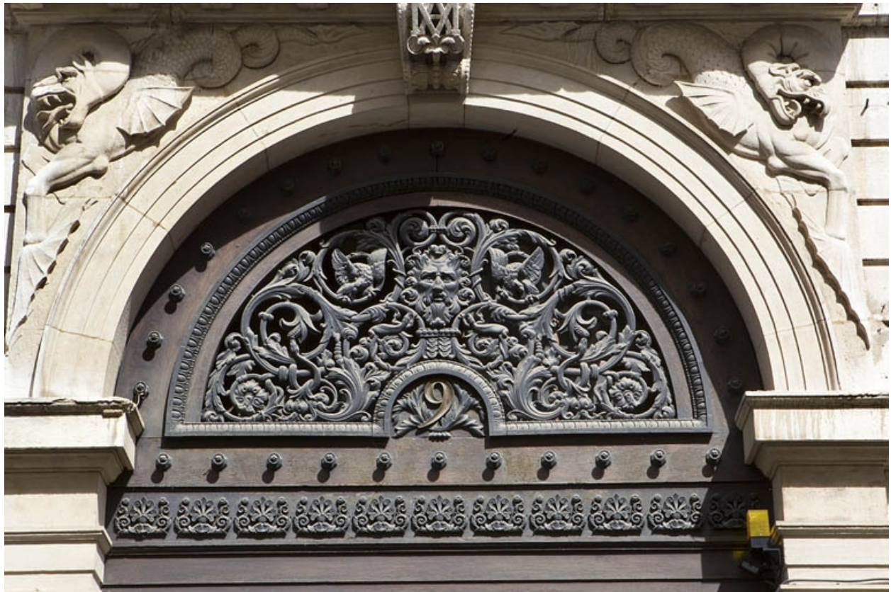
Portail d'entrée : détail du tympan.
