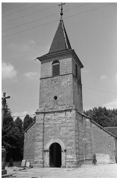
Eglise paroissiale Saint-Symphorien. Phot. Guy Forestier IVR43_19743900336Z
