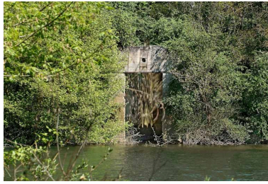
Un garage à bateau (?) sur la rive gauche de la Seille, en bas du parc du château de Saint-Romain. Phot. Jean-Luc Duthu IVR26_20107100556NUC2A
