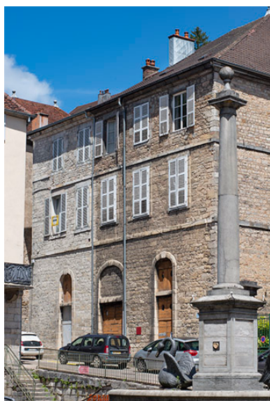
Bâtiment sur rue vu de trois quarts droite. Phot. Jérôme Mongreville IVR43_20243900676NUC4A
