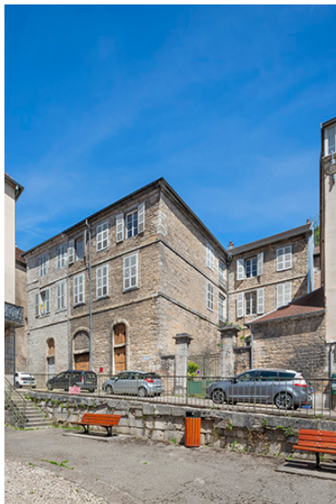
Vue d'ensemble depuis la place dite des Cygnes. Phot. Jérôme Mongreville IVR43_20243900679NUC4A
