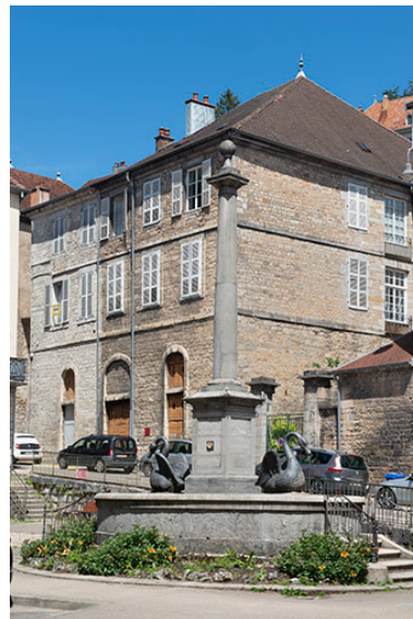
Vue rapprochée depuis le sud-ouest. Phot. Jérôme Mongreville IVR43_20243900677NUC4A
