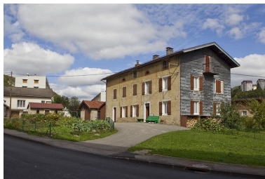
Ferme 42-44 rue Pasteur Phot. Yves Sancey IVR43_20103900462NUC2A
