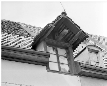
Façade sur rue. Fenêtre de service. Phot. Jérôme Mongreville IVR43_19872500886X
