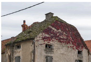
Détail de la toiture depuis le nord-ouest. Phot. Pierre-Marie Barbe-Richaud IVR26_20222101042NUC4A
