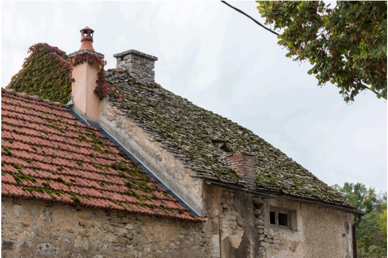
Détail de la toiture depuis le nord-est.
