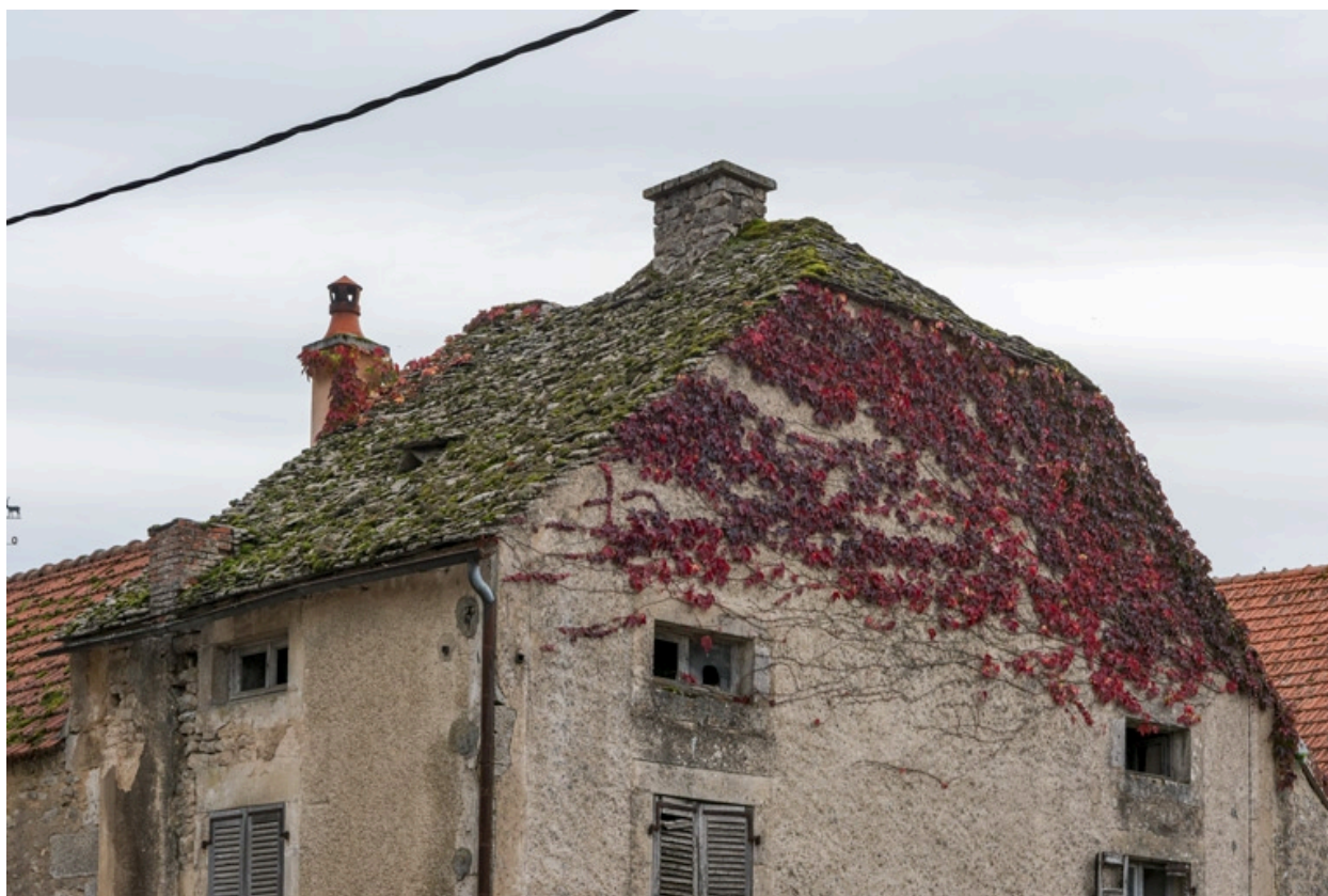
Détail de la toiture depuis le nord-ouest.
