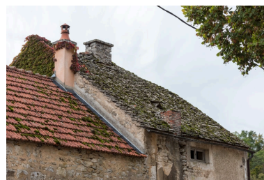
Détail de la toiture depuis le nord-est. Phot. Pierre-Marie Barbe-Richaud IVR26_20222101041NUC4A
