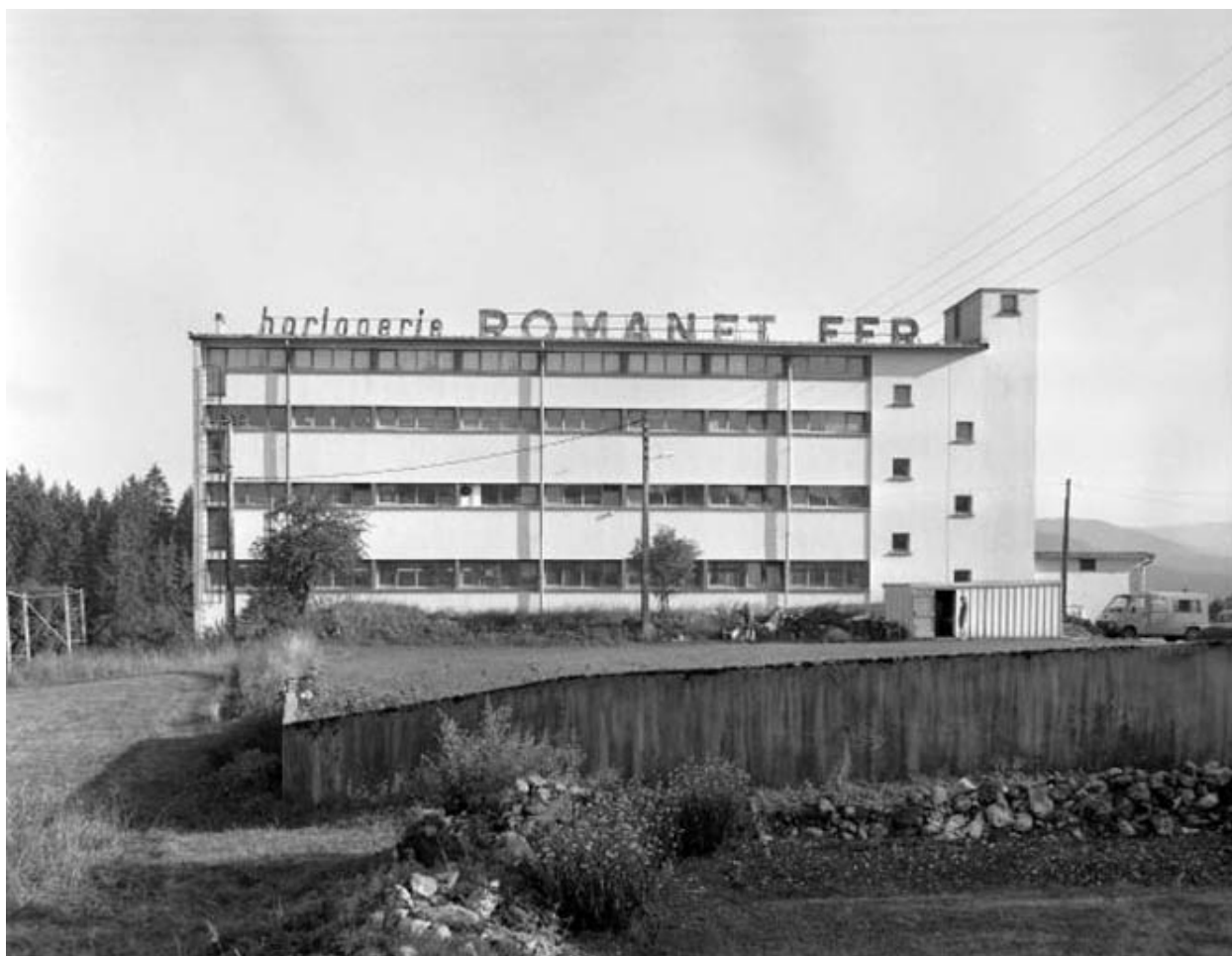
Façade postérieure du bâtiment de 1961.
