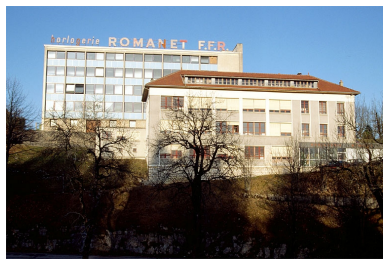
Façade antérieure des bâtiments.
