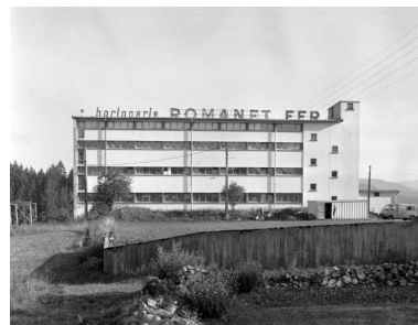
Façade postérieure du bâtiment de 1961.
