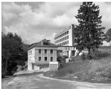
Façade latérale droite des bâtiments.
