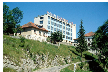
Vue d'ensemble depuis l'ouest. Phot. Laurent Poupard IVR43_19913901570ZA
