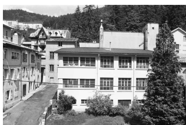
2 rue Raspail : atelier de fabrication. Phot. Laurent Poupard IVR43_19913901473Z
