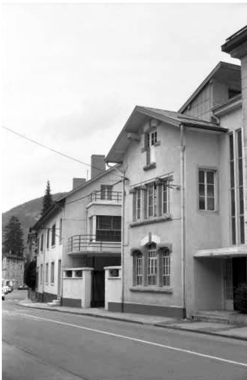
Rue de la République : vue d'ensemble.
