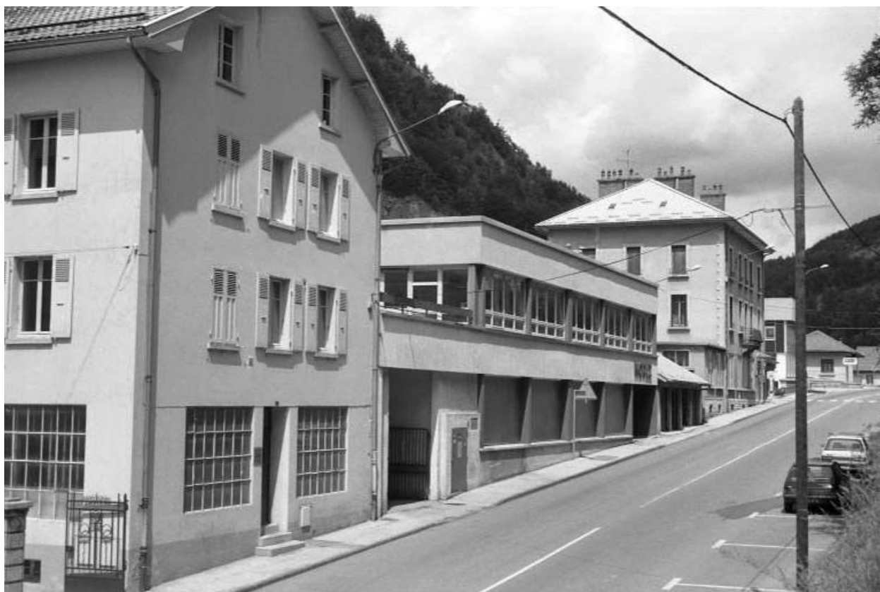
Avenue Charles de Gaulle : vue d'ensemble.
