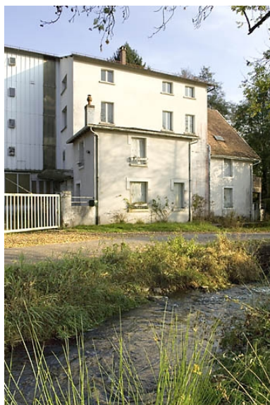
Élévation de l'atelier de fabrication. Phot. Jérôme Mongreville IVR43_20077000633NUCA
