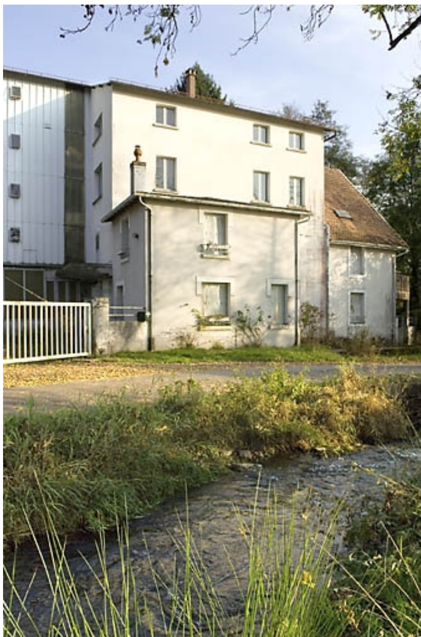
Elévation de l'atelier de fabrication.
