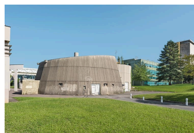
Vue d'ensemble, depuis le sud-est. Phot. Pierre-Marie Barbe-Richaud IVR26_20212100069NUC4A
