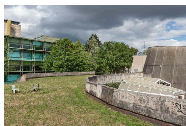
Aile semi-circulaire : toiture végétalisée. Phot. Pierre-Marie Barbe-Richaud IVR26_20212100068NUC4A
