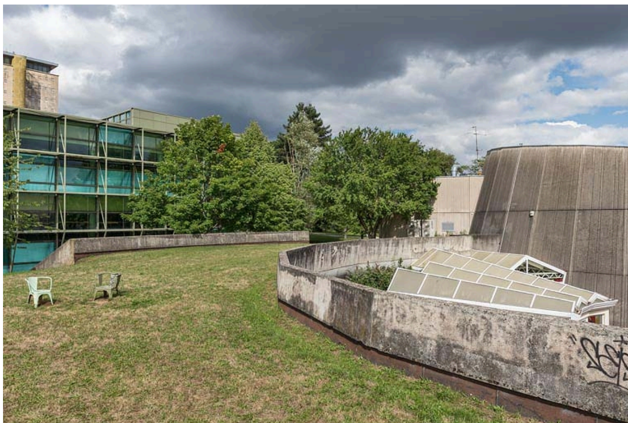
Aile semi-circulaire : toiture végétalisée.
