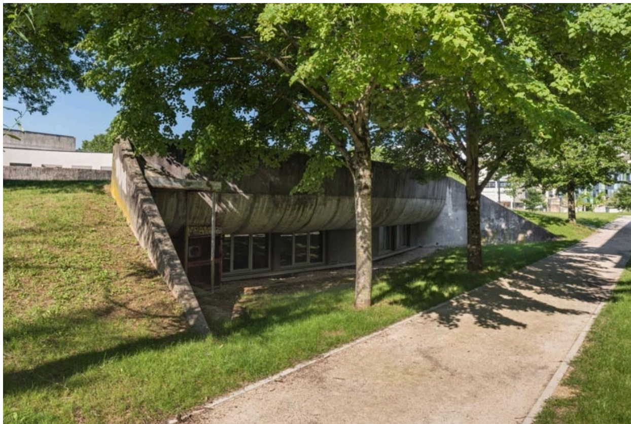
Aile semi-circulaire : fenêtre au nord.
