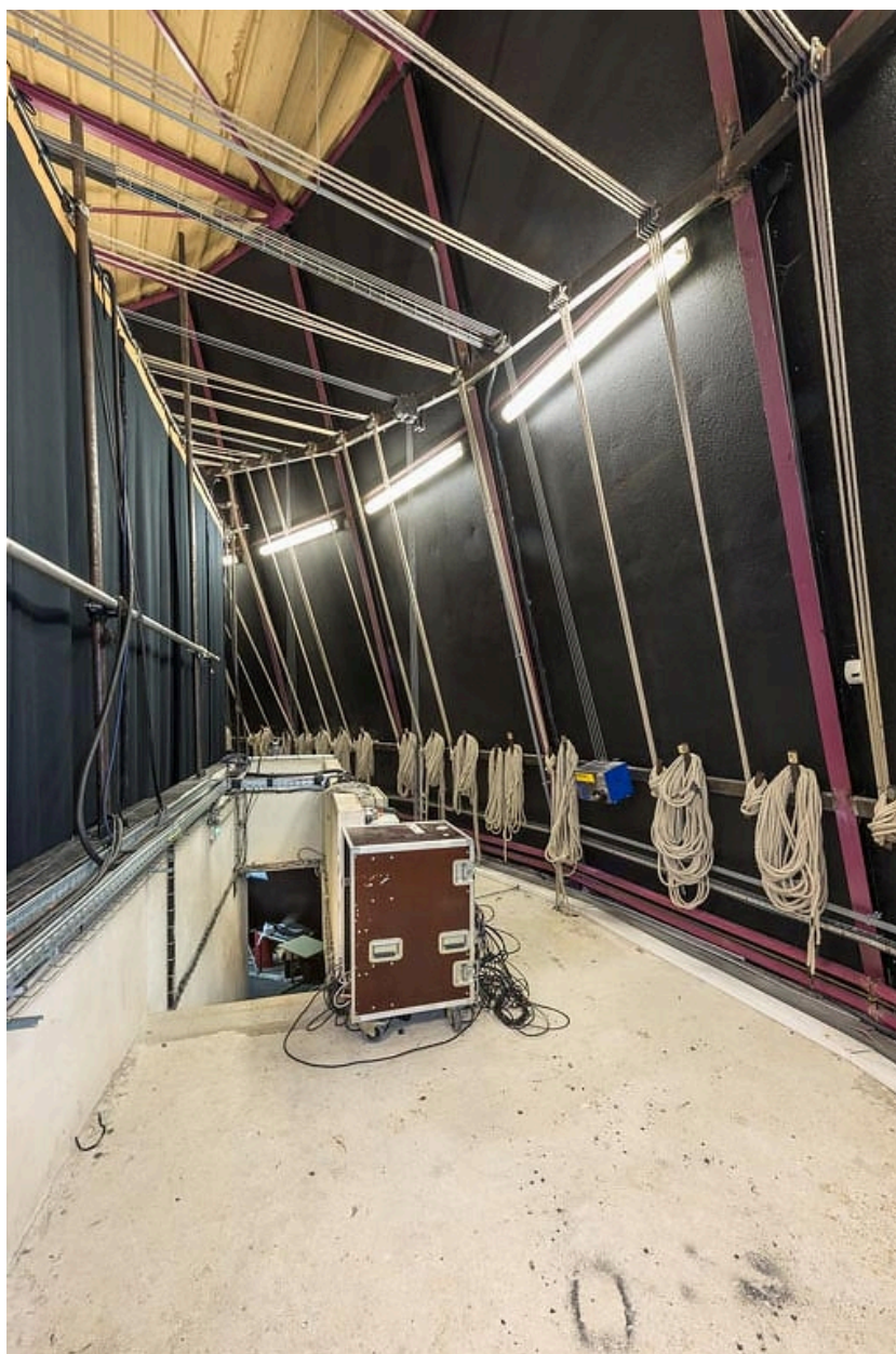
Salle : circulation latérale et charpente métallique.
