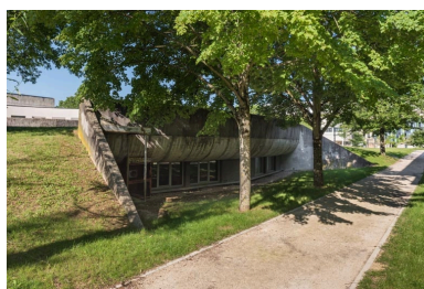
Aile semi-circulaire : fenêtre au nord. Phot. Pierre-Marie Barbe-Richaud IVR26_20212100071NUC4A
