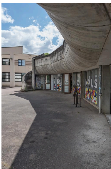
Aile semi-circulaire : toiture formant auvent côté cour. Phot. Pierre-Marie Barbe-Richaud IVR26_20212100076NUC4A
