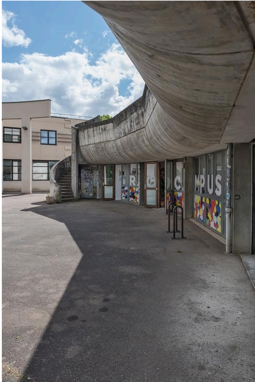
Aile semi-circulaire : toiture formant auvent côté cour.
