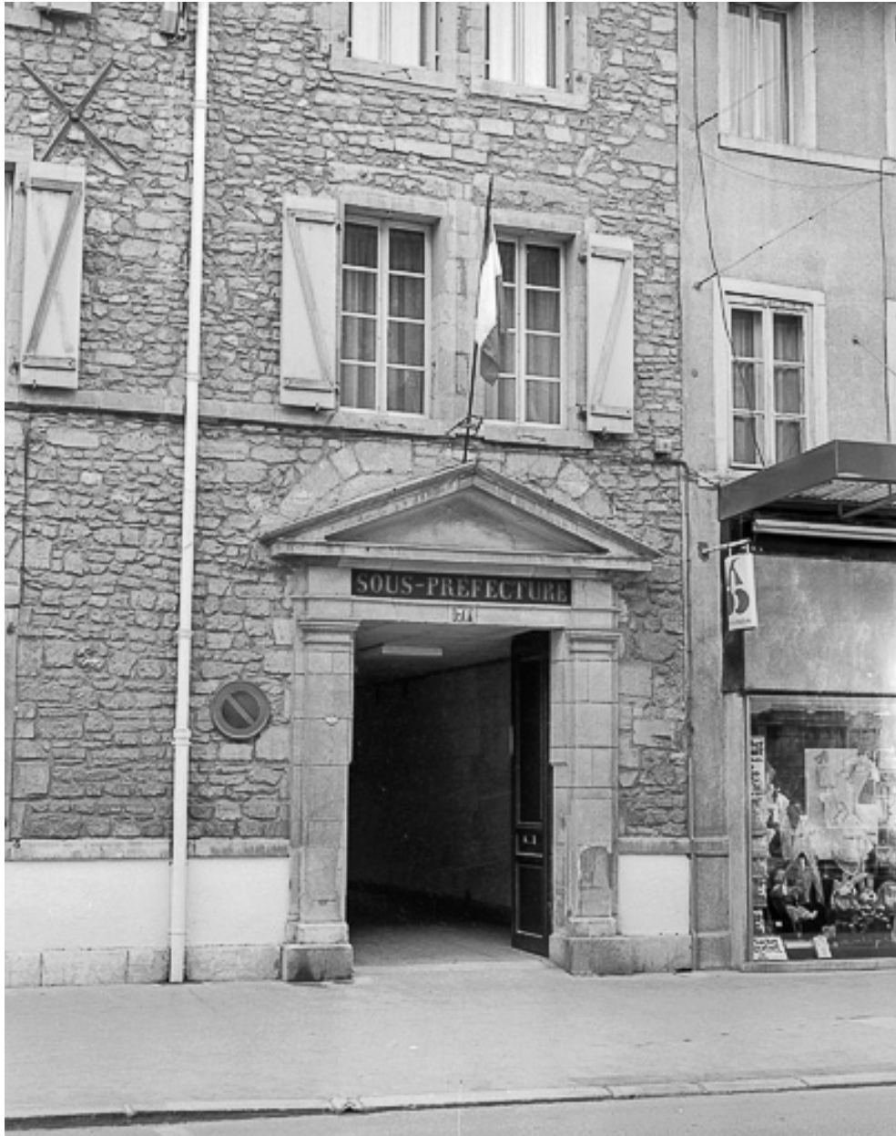
Le portail d'entrée du couvent.
