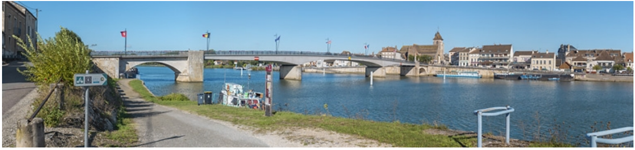
Vue d'ensemble depuis Losne, rive gauche.
