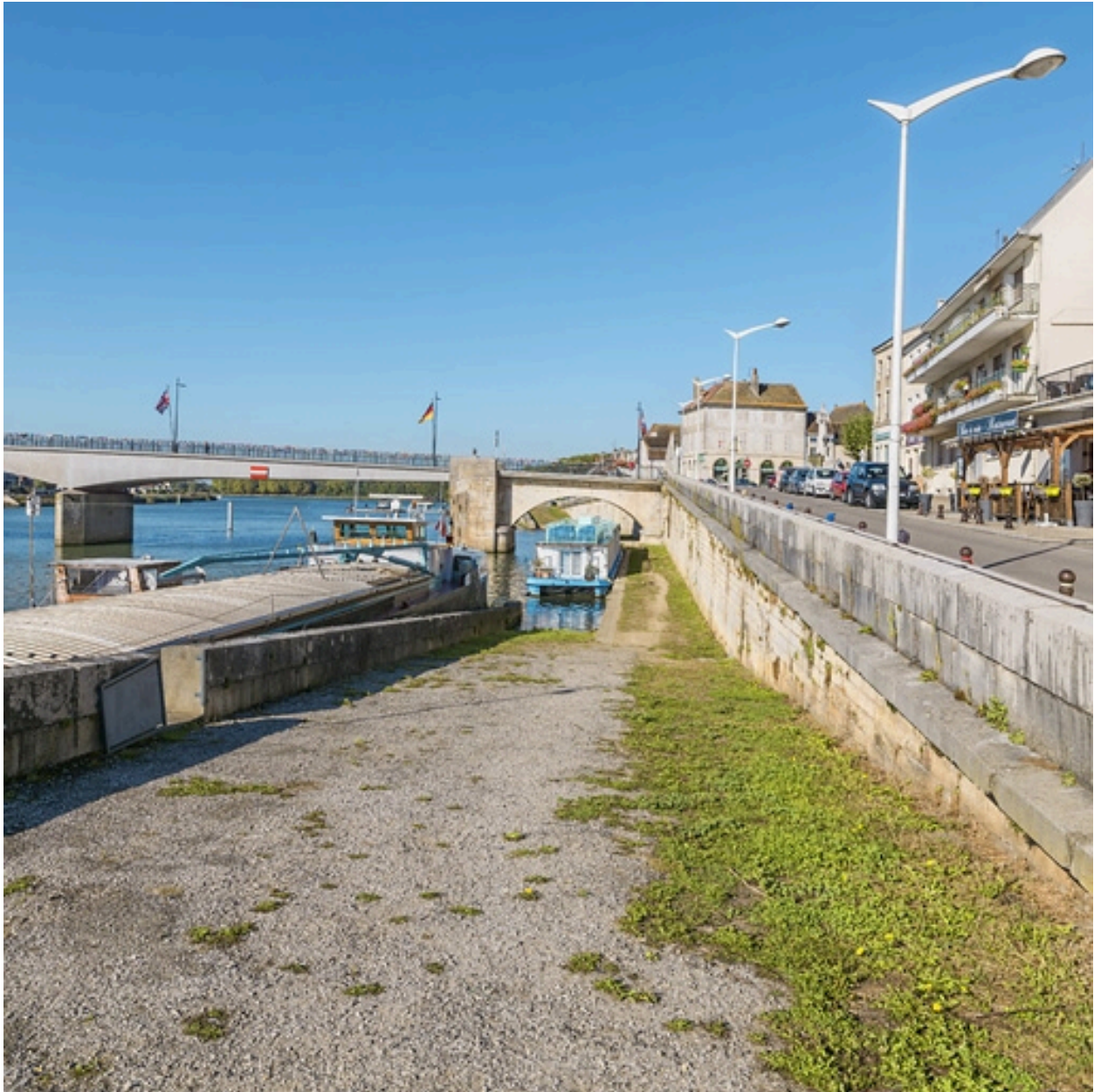
Arche maçonnée du pont, rive droite.
