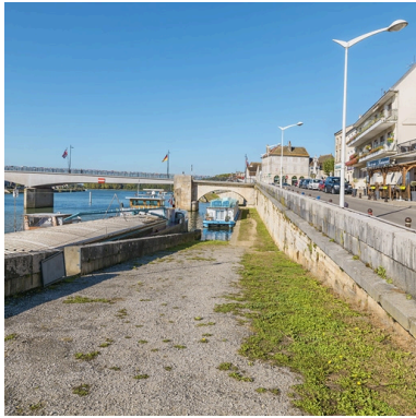
Arche maçonnée du pont, rive droite.
