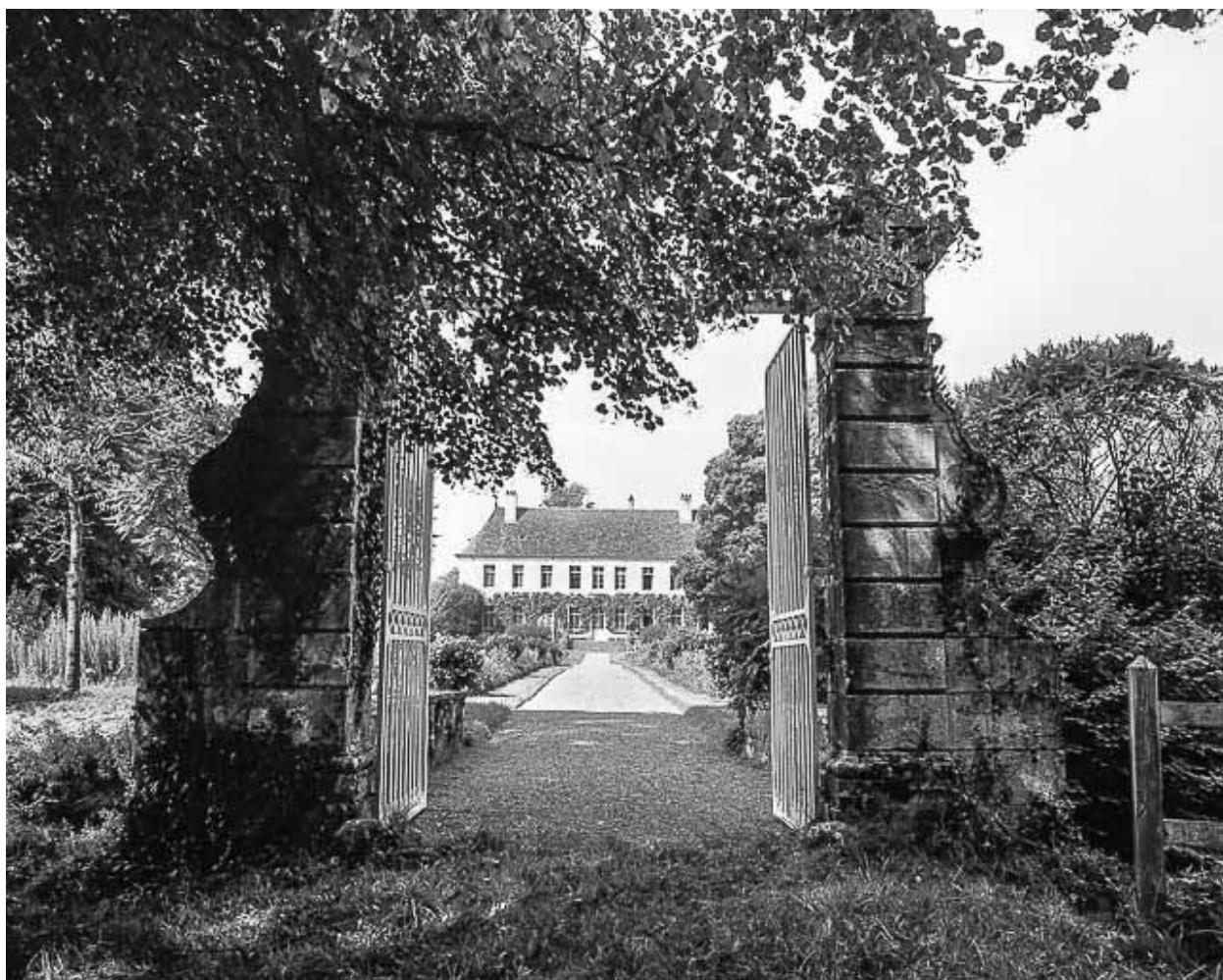
Façade postérieure depuis l'entrée.
