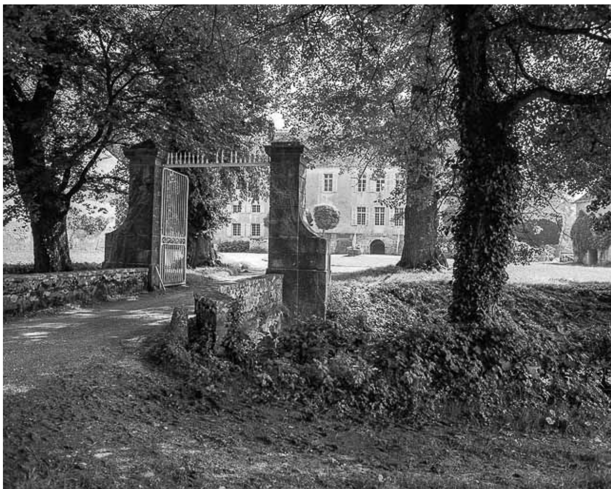
Façade antérieure avec entrée.
