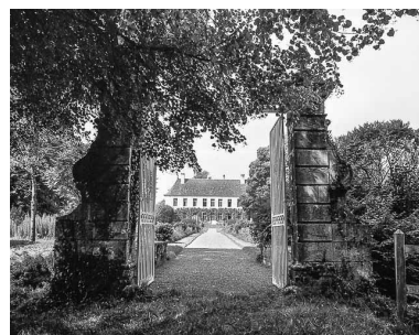
Façade postérieure depuis l'entrée. Phot. Yves Sancey IVR43_19757000310X
