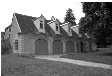
Les remises. Phot. Bernard Lardière IVR43_19817000443Z
