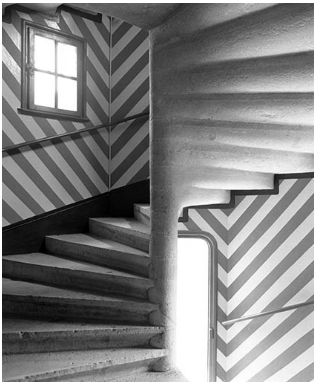
Intérieur : détail de la tour d'escalier.
