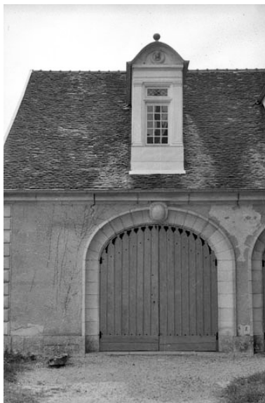
Les remises : détail d'une porte. Phot. Bernard Lardière IVR43_19817000444Z
