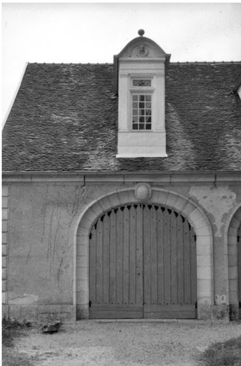
Les remises : détail d'une porte.
