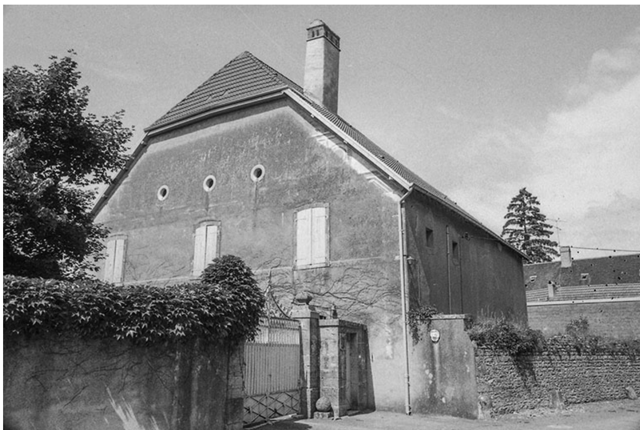
Logement de domestique.
