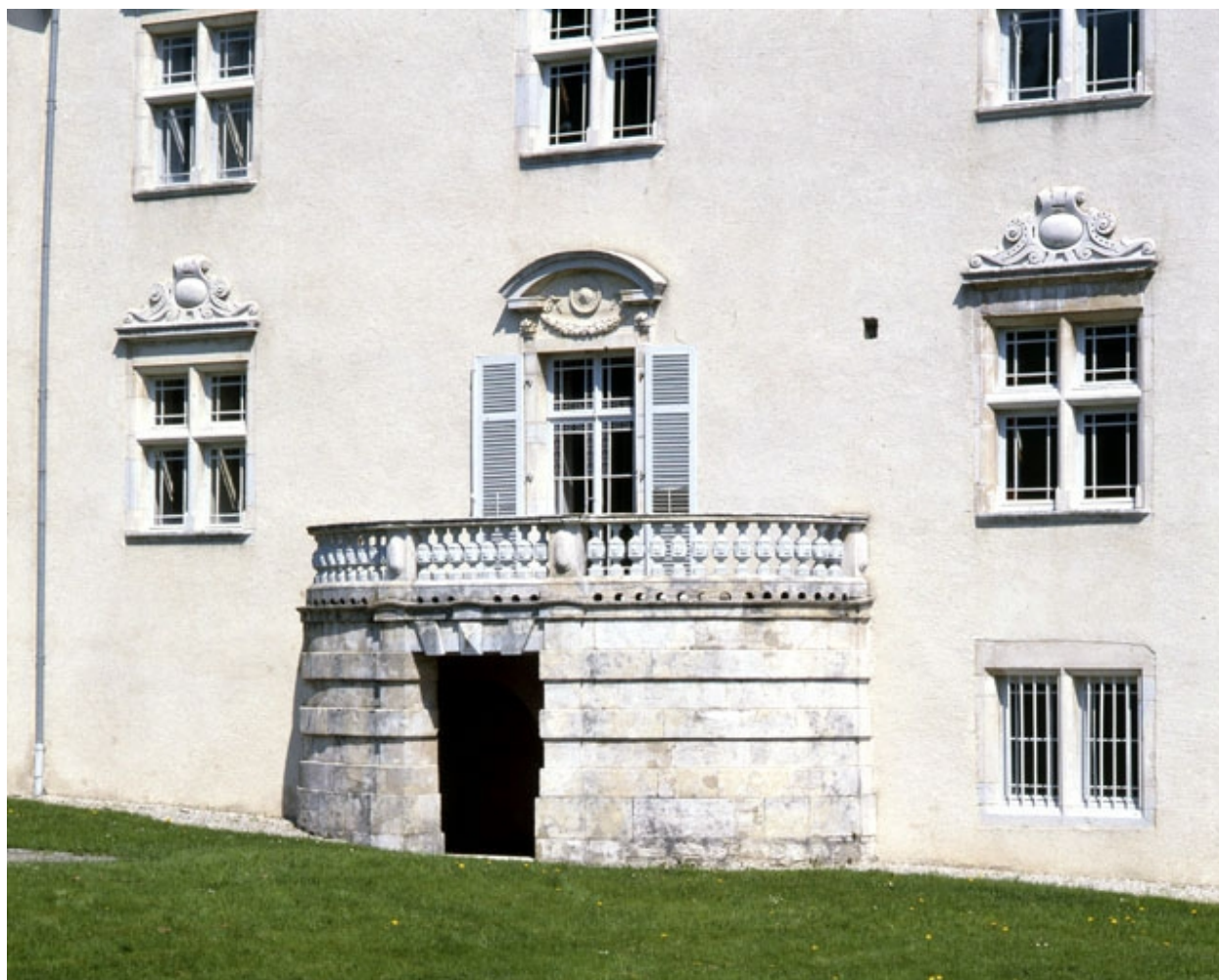
Détail : balcon façade postérieure.
