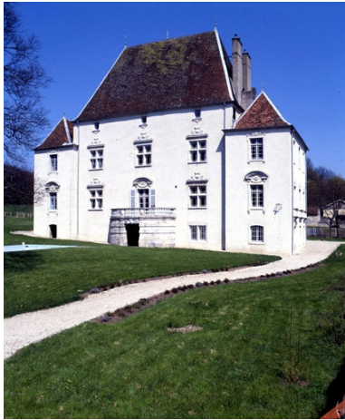
Façade postérieure. Phot. Yves Sancey IVR43_19857000067XA
