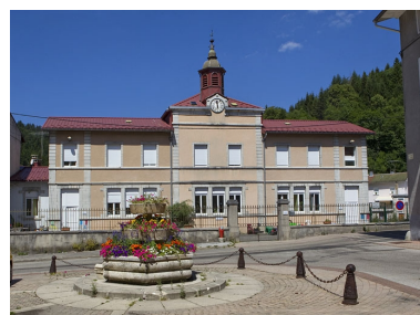
Vue d'ensemble, depuis la place Jules Girod. Phot. Yves Sancey IVR43_20103900367NUC2A
