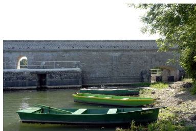
Vanne de fond et déversoir de superficie. Phot. Alain Morelière IVR26_20072106041NUC2A
