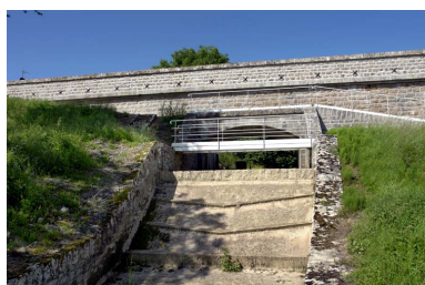
Déversoir de superficie du réservoir, prolongé par une chute d'eau en trois paliers et surmonté d'une passerelle. Phot. Alain Morelière IVR26_20072106043NUC2A
