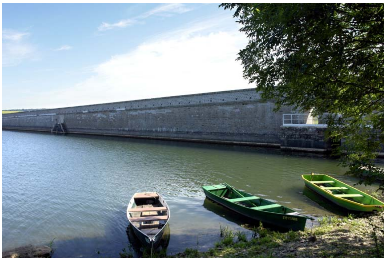
Vue d'ensemble du barrage, face réservoir.
