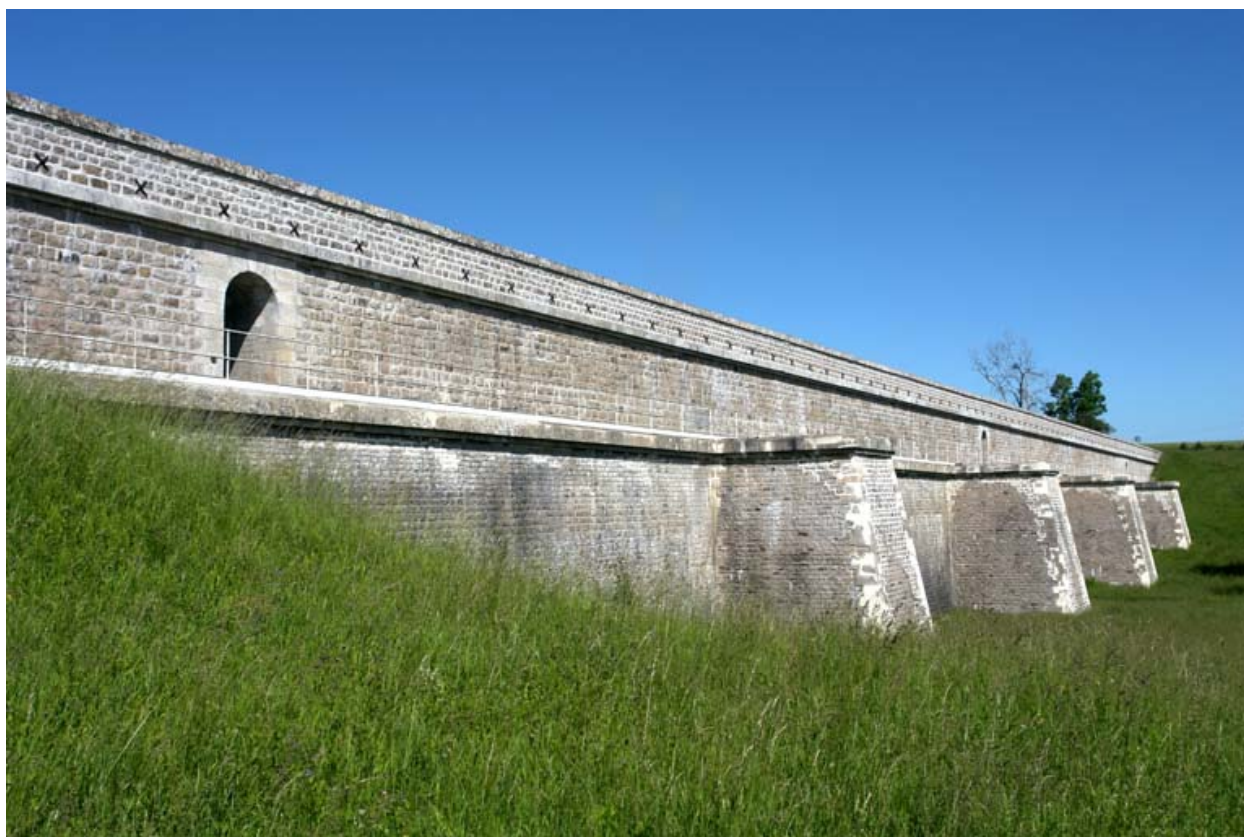
Face avant du barrage, vue d'ensemble.
