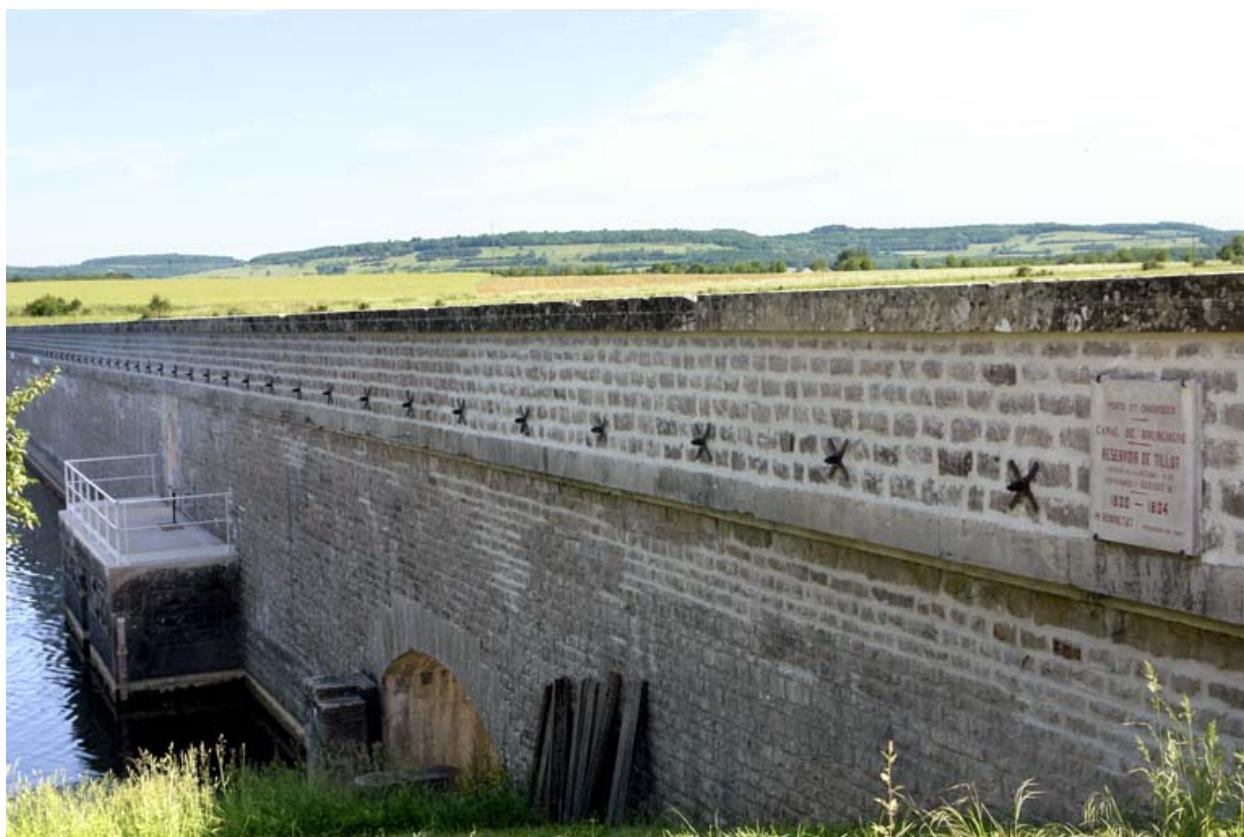
Le barrage, face réservoir.
