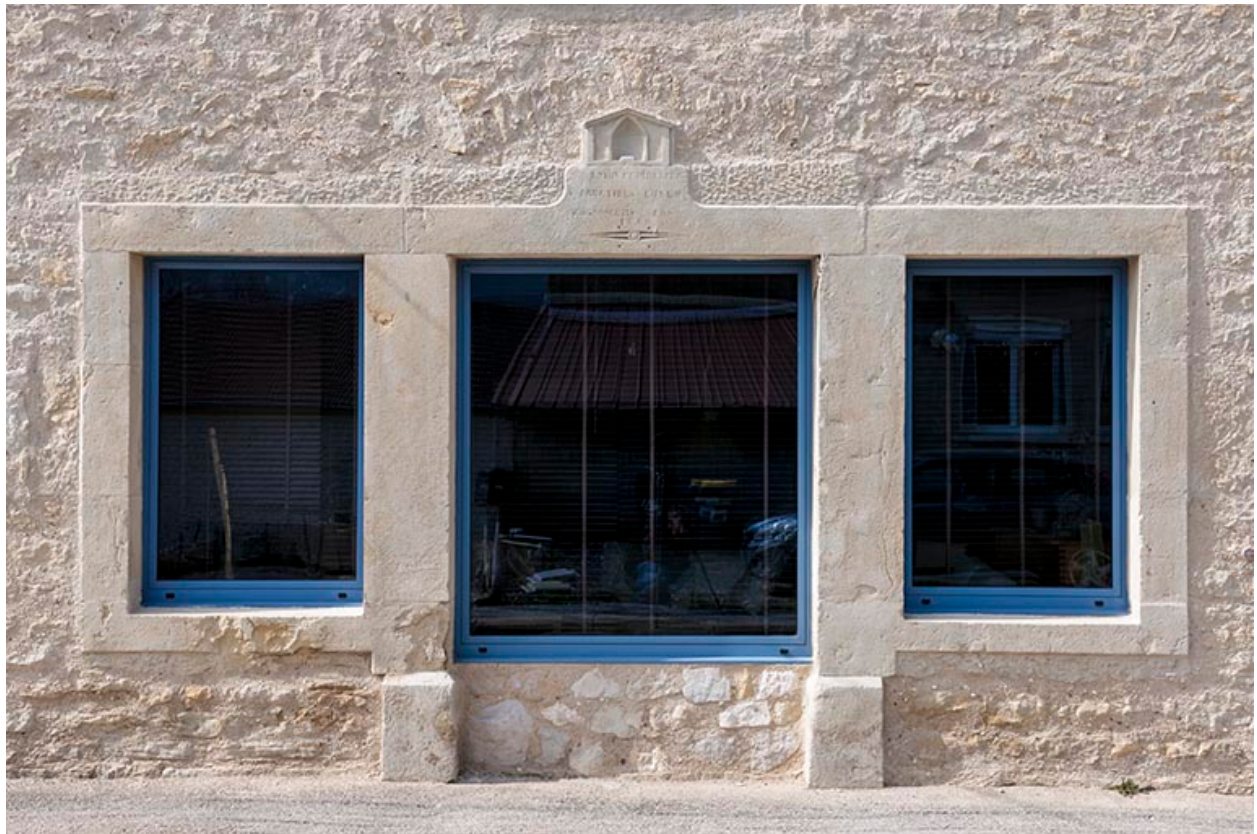
Ouvertures du mur-pignon est.
