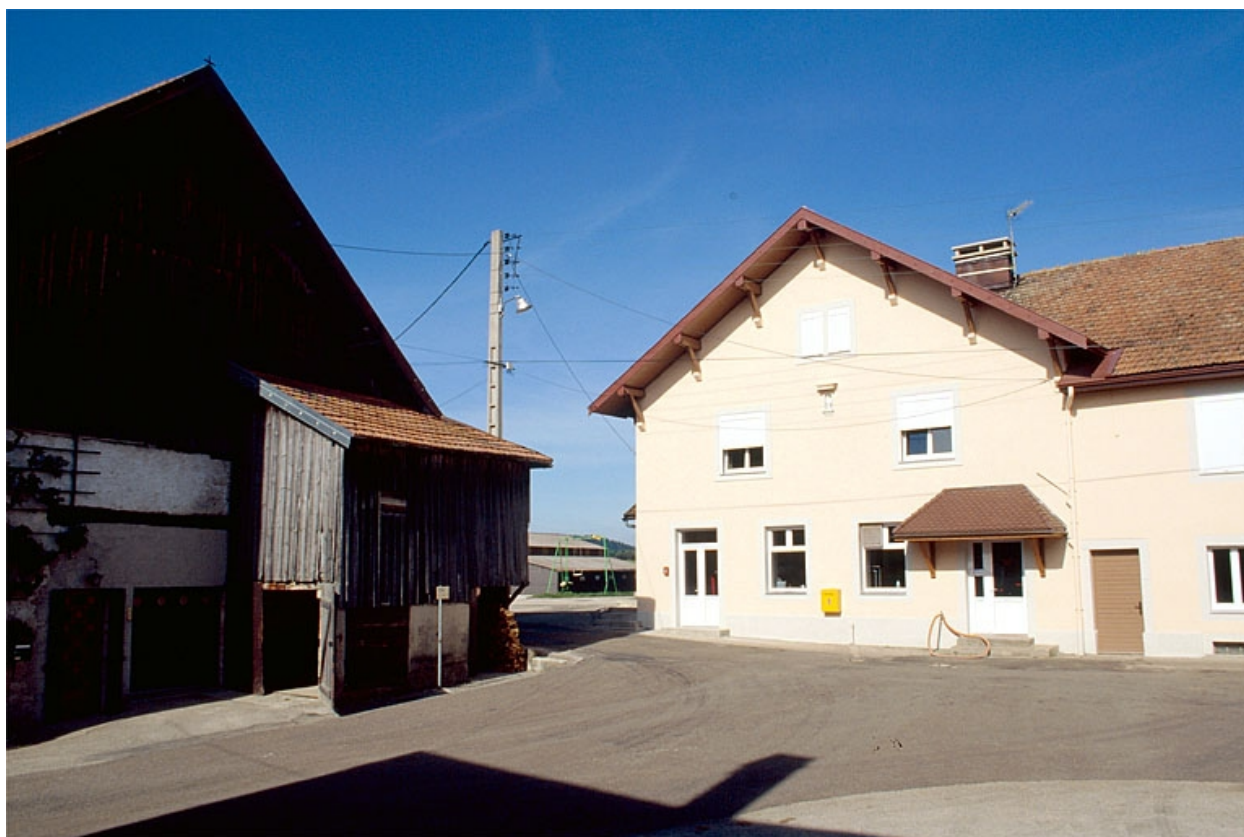
Pignon sud-est de la fromagerie.
