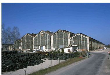
Elévation sud-ouest de la grande halle.
