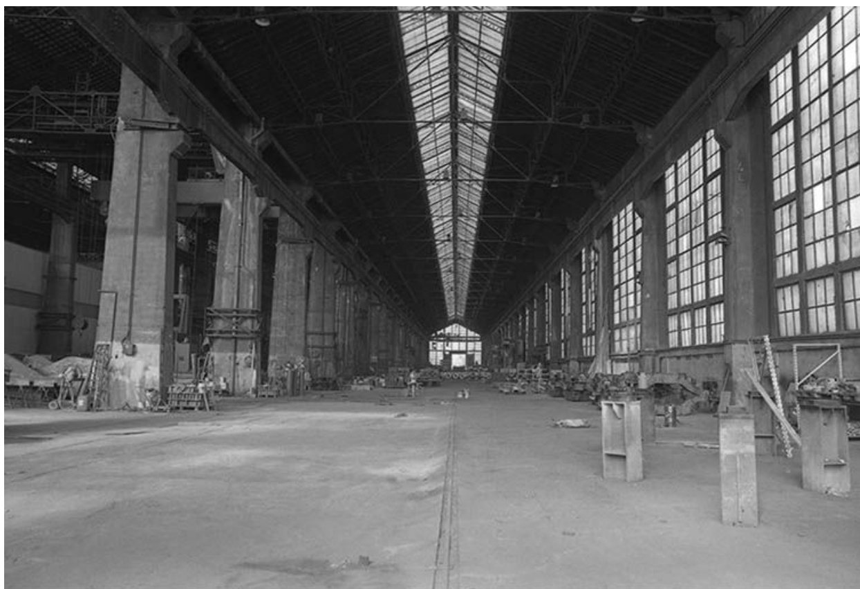
Intérieur de la travée E de la fonderie de fonte, vu de l'entrée nord.
