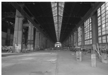
Intérieur de la travée E de la fonderie de fonte, vu de l'entrée nord.
