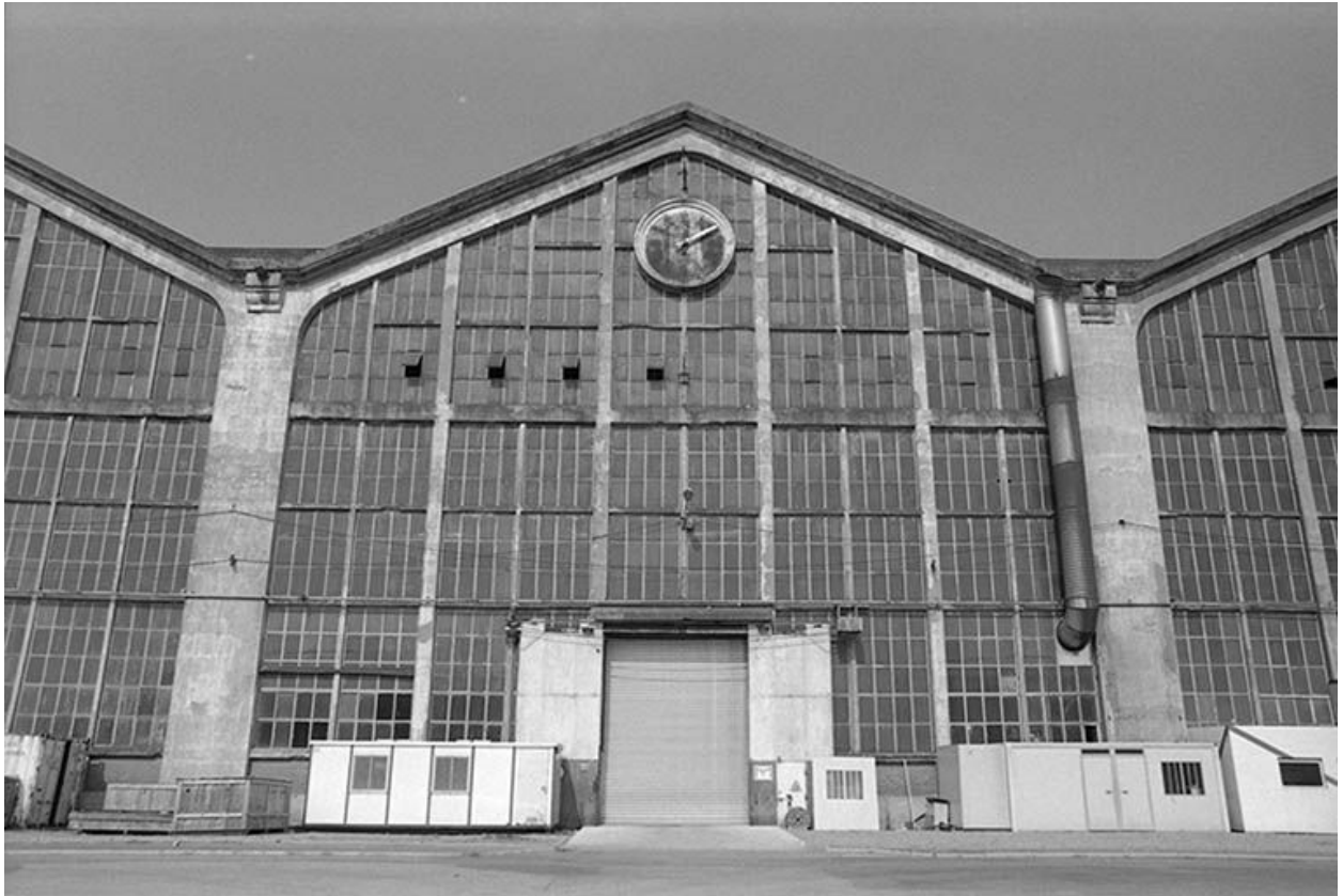
Façade antérieure de la travée centrale (C) de la fonderie de fonte.
