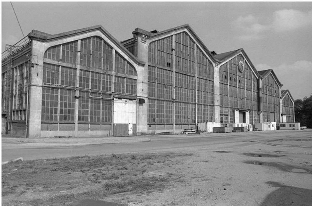
Façade antérieure de la fonderie de fonte, vue du nord-est.
