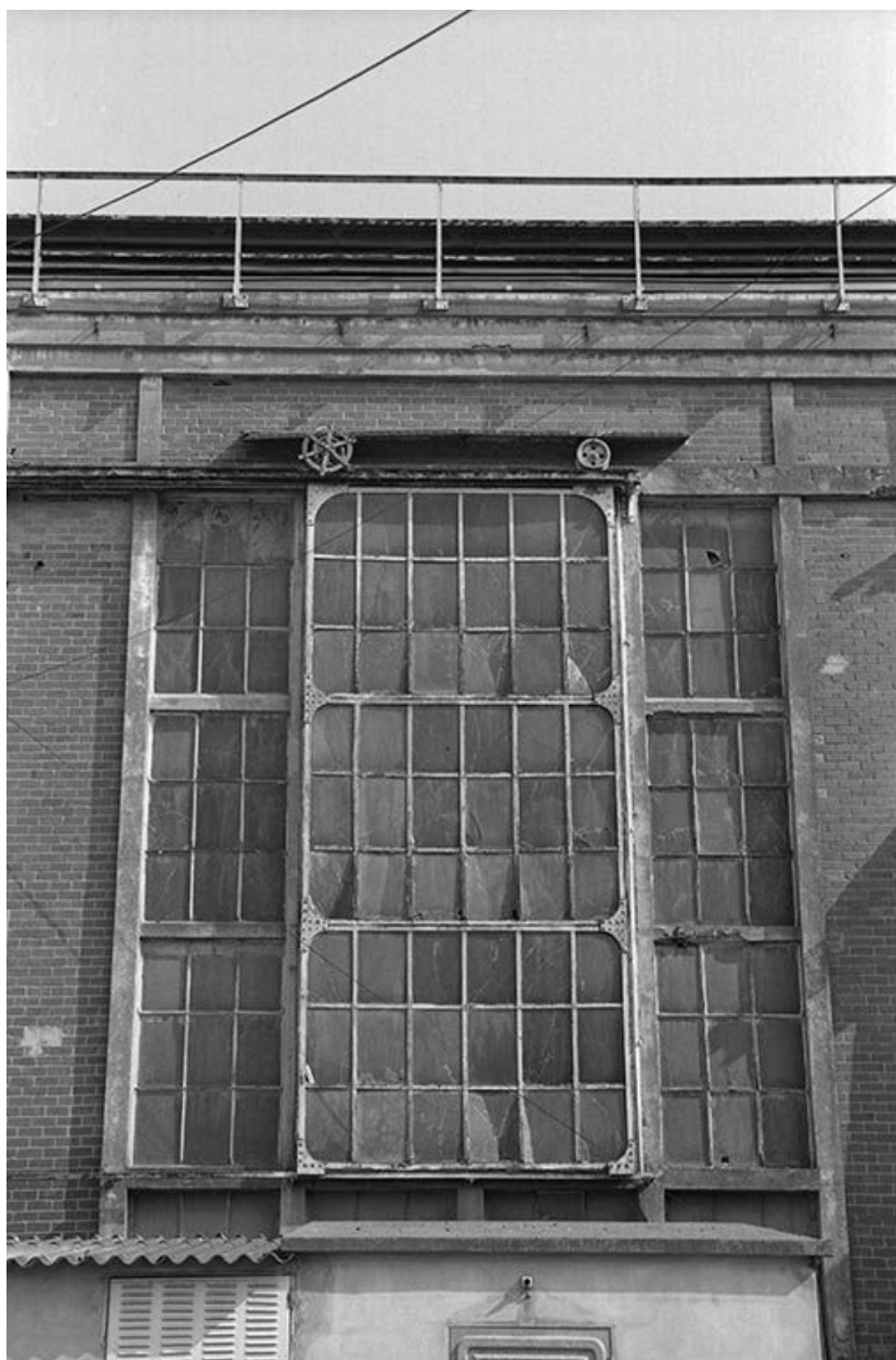
Détail d'une baie et de son mécanisme de châssis roulant, travée A, mur ouest de la fonderie de fonte.
