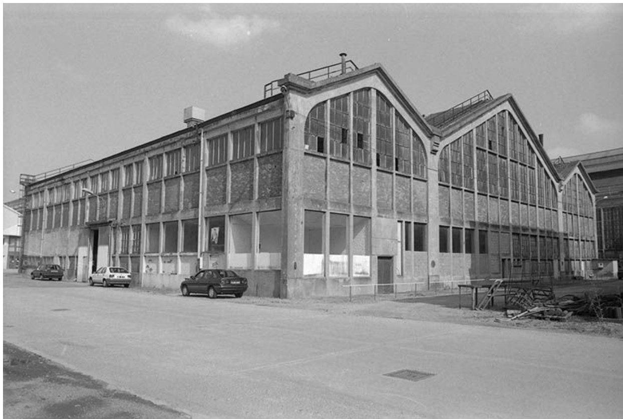
Magasin, vestiaires et douches vus de l'ouest.
