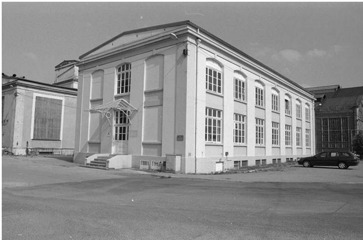
Bureaux généraux, vus de l'ouest.
