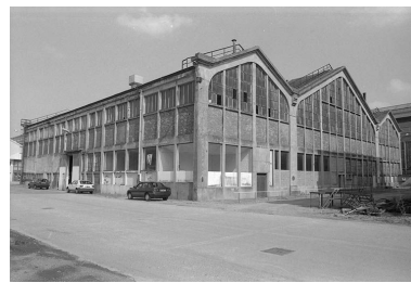
Magasin, vestiaires et douches vus de l'ouest.
