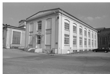
Bureaux généraux, vus de l'ouest.
