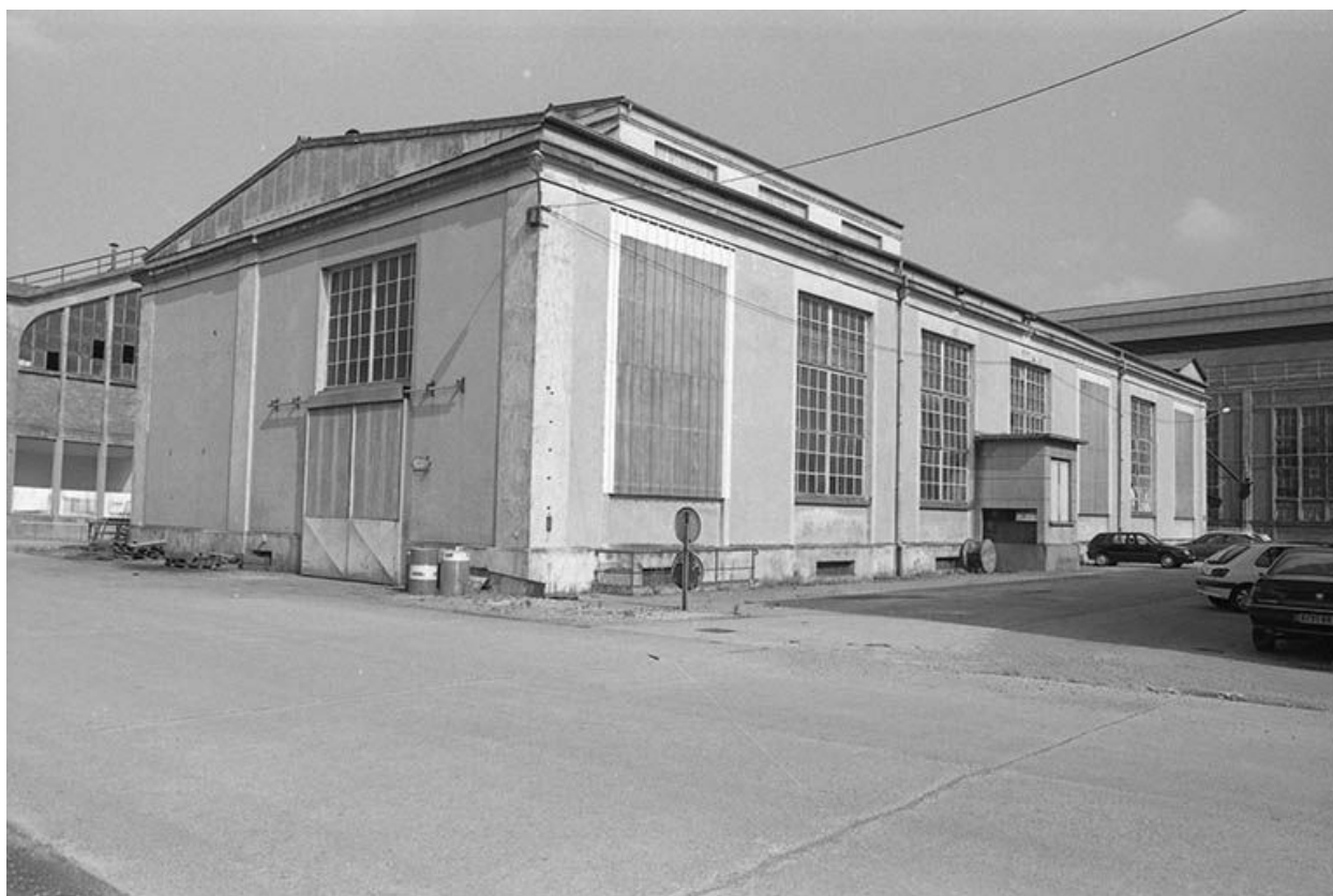
Sous-station électrique, vue de l'ouest.
