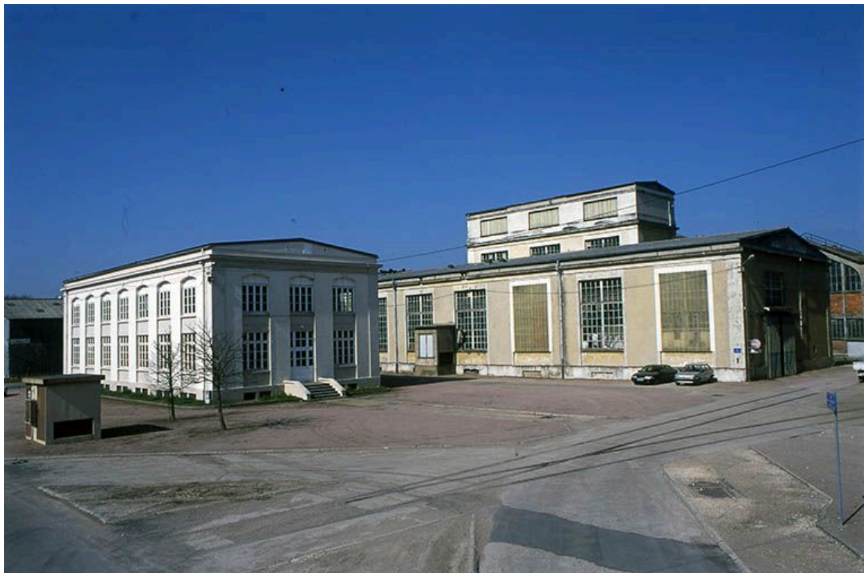
Bâtiments secondaires à l'ouest de la grande halle.
