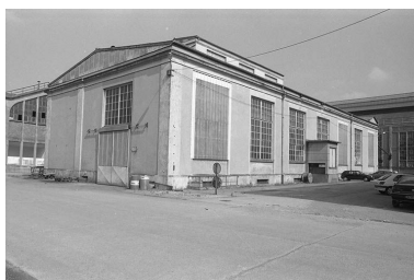
Sous-station électrique, vue de l'ouest.
