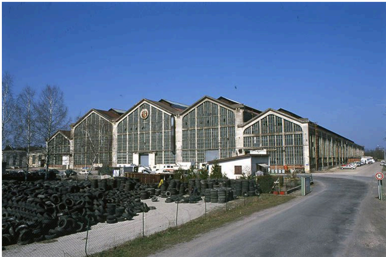
Élévation sud-ouest de la grande halle.
