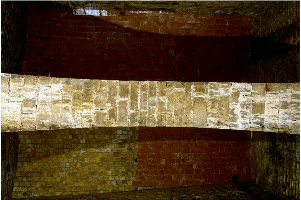
Voûtes en berceau segmentaire de briques du puits à Muire.
