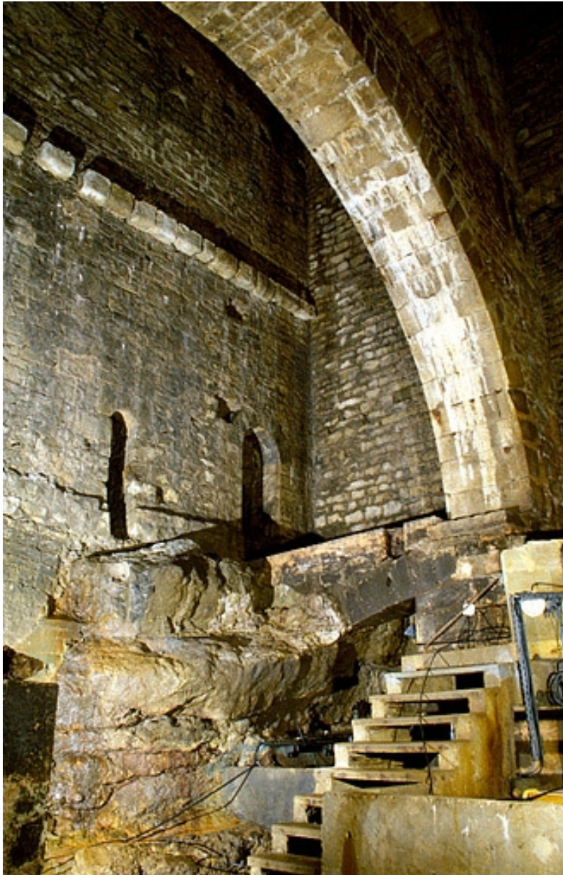
Mur sud du puits depuis le niveau inférieur. La principale source salée jaillit à gauche de l'escalier.
