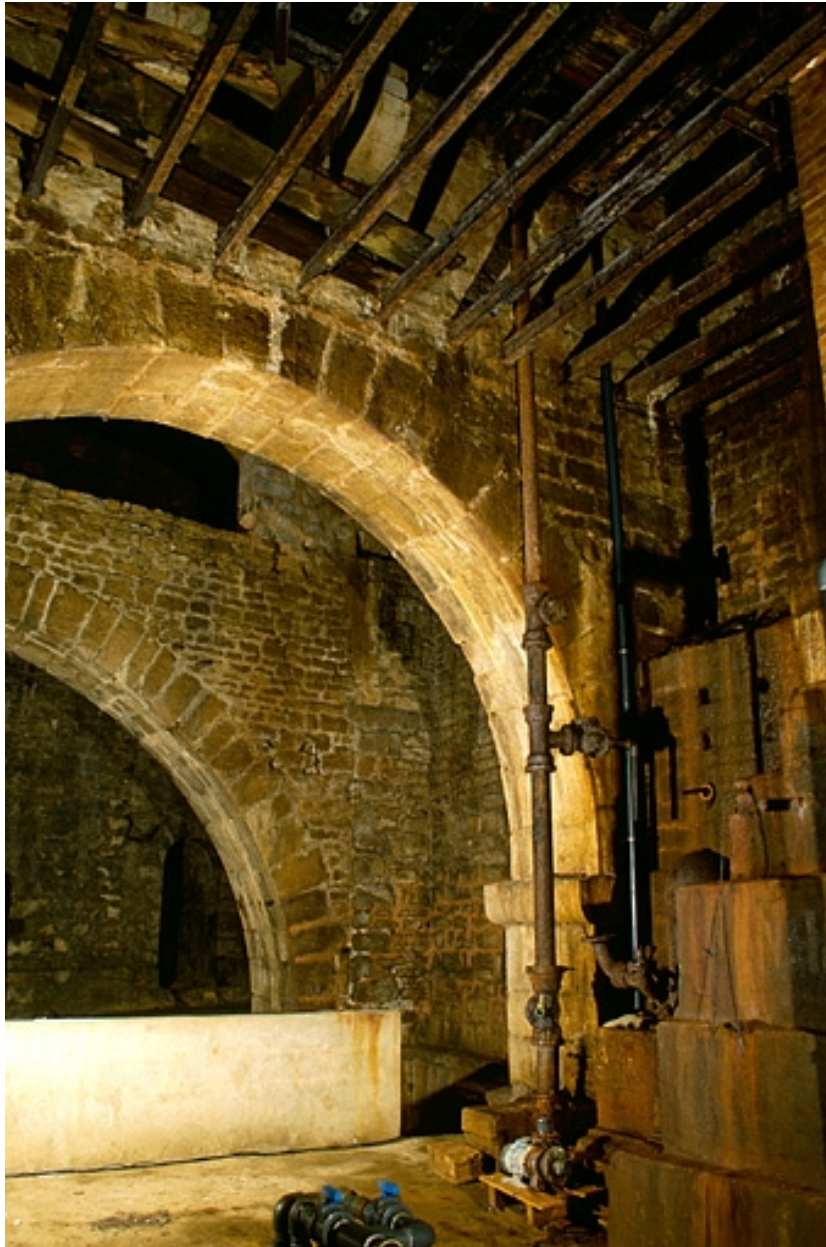
Arcs-diaphragmes sud. Les deux baies cintrées visibles dans le mur du fond donnaient accès à une ancienne source.
