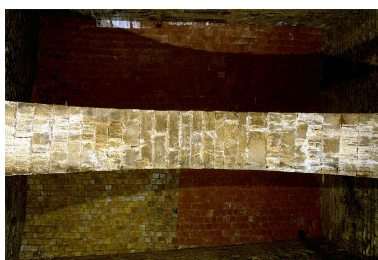
Voûtes en berceau segmentaire de briques du puits à Muire. Phot. Yves Sancey IVR43_19973902032ZA
