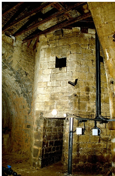
Escalier en vis débouchant au fond du puits. Phot. Yves Sancey IVR43_19973902019ZA
