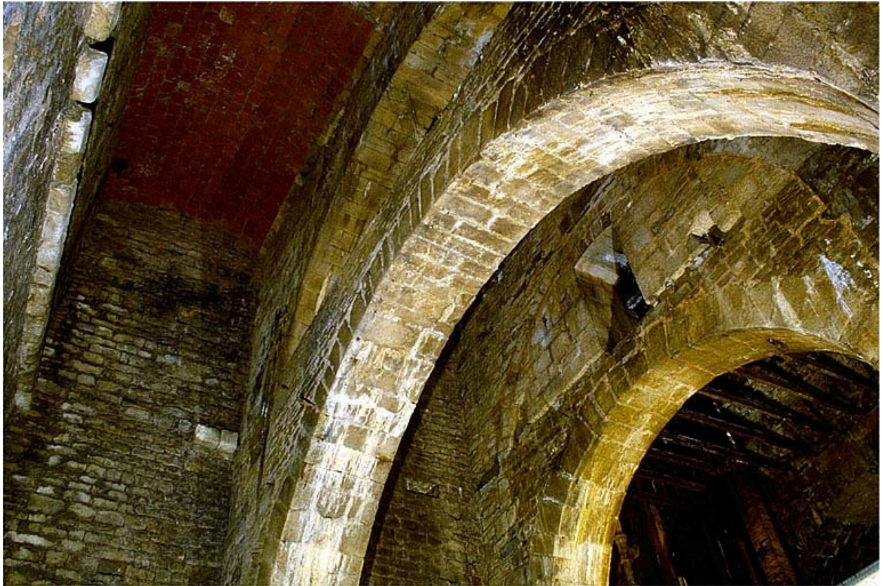
Arcs-diaphragmes et voûtement du puits.
