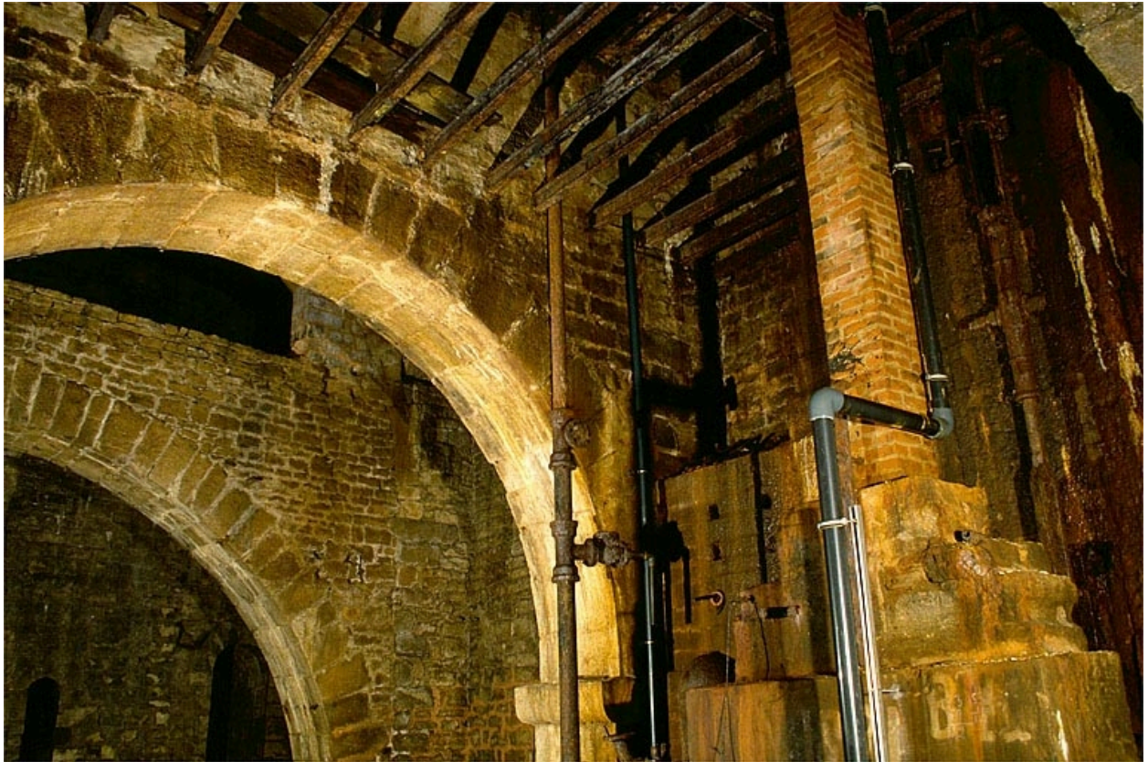
Parties supérieures du puits à Muire.
