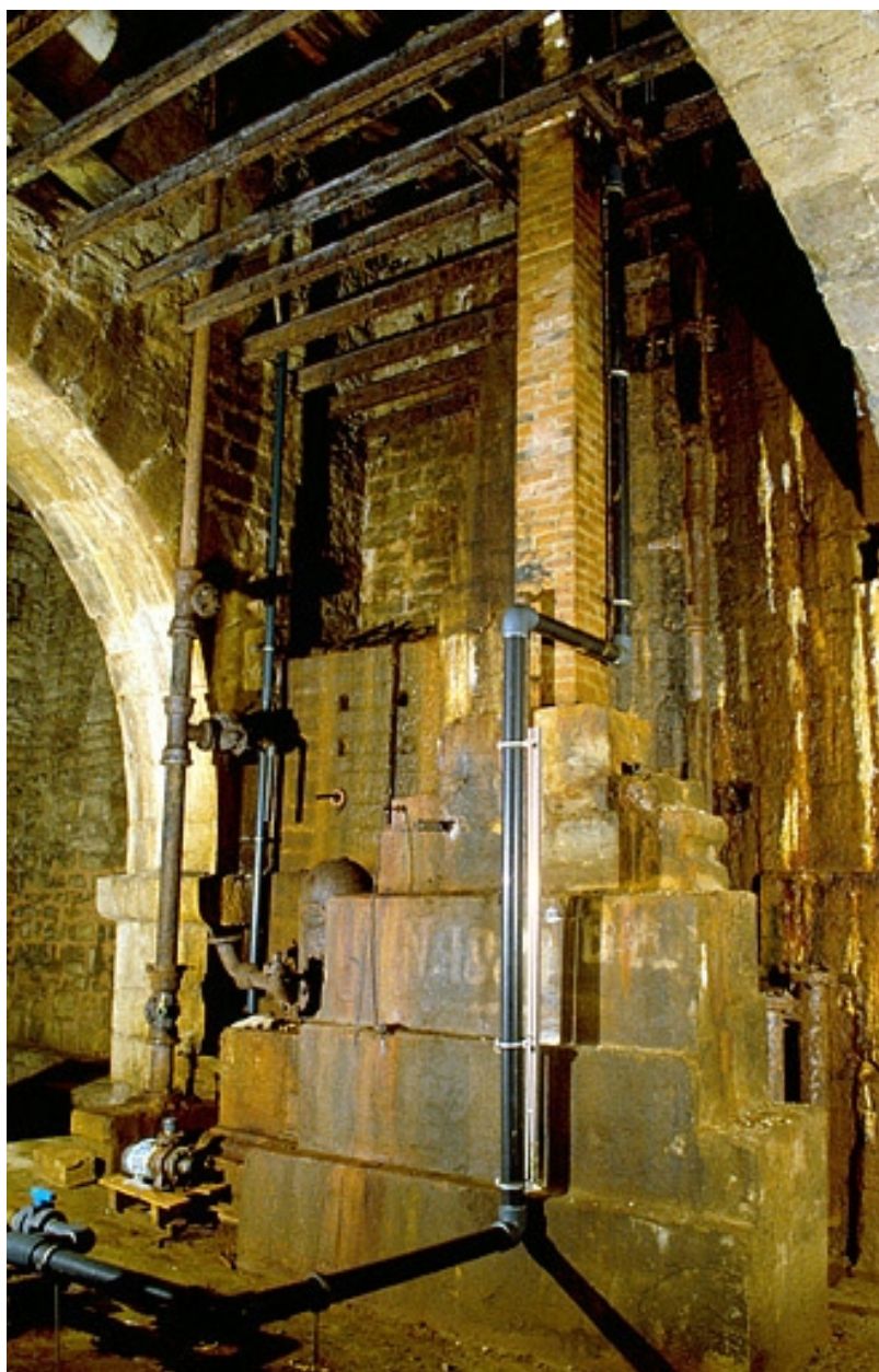
Massif de maçonnerie supportant les installations de pompage. A gauche, les anciennes canalisations de remontée de l'eau salée (hors d'usage).
