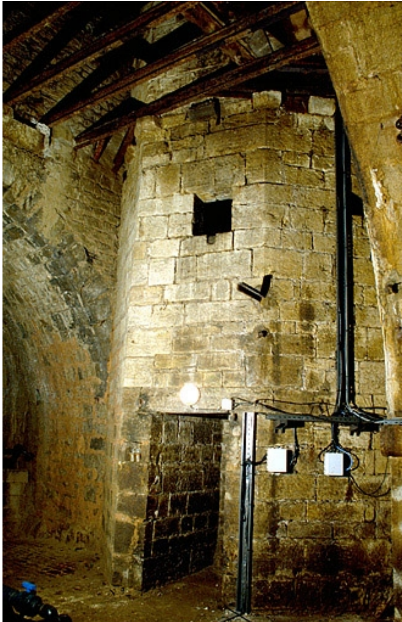
Escalier en vis débouchant au fond du puits.
