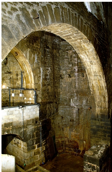
Vue plongeante sur le fond du puits. Phot. Yves Sancey IVR43_19973902037ZA
