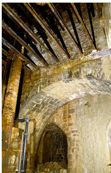
Angle nord-ouest du puits en contre-plongée. Phot. Yves Sancey IVR43_19973902033ZA
