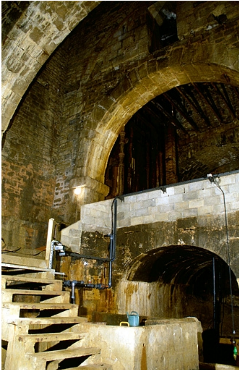
Vue d'ensemble depuis le niveau inférieur, à l'angle sud-est. Au centre, bassin de stockage de l'eau salée pour l'établissement thermal.
