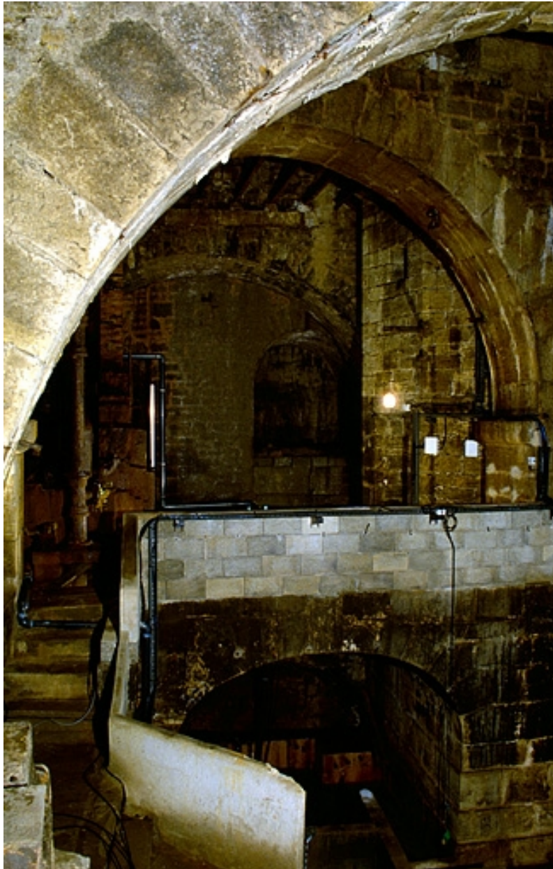
Vue d'ensemble depuis l'angle sud-ouest.
