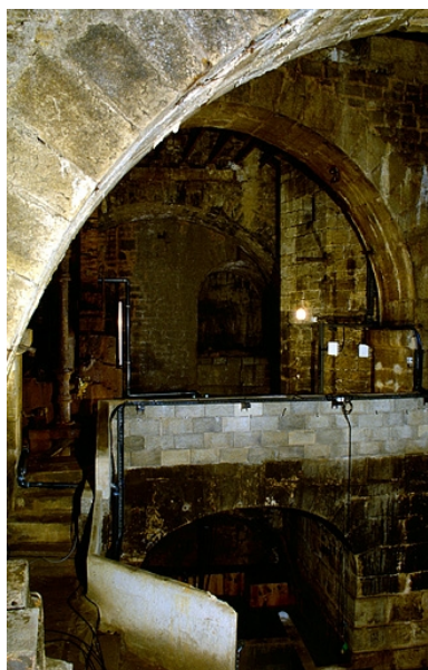
Vue d'ensemble depuis l'angle sud-ouest. Phot. Yves Sancey IVR43_19973902035ZA
