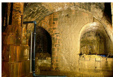
Mur nord du puits. La niche de gauche, comblée, donnait accès à une source salée. Phot. Yves Sancey IVR43_19973902028ZA
