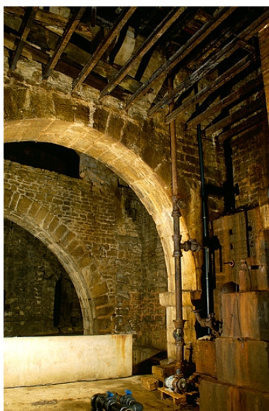
Arcs-diaphragmes sud. Les deux baies cintrées visibles dans le mur du fond donnaient accès à une ancienne source. Phot. Yves Sancey IVR43_19973902021ZA
