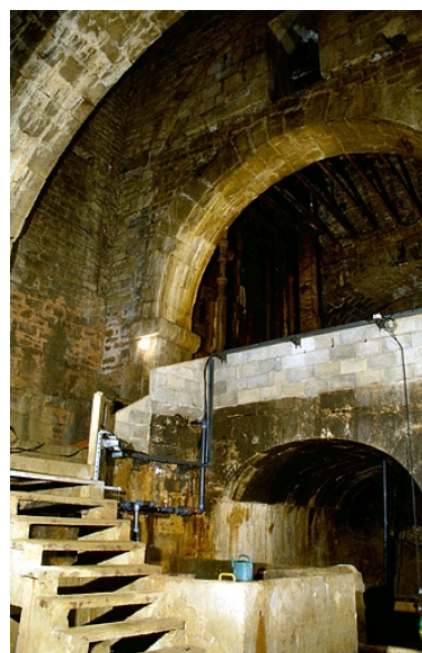
Vue d'ensemble depuis le niveau inférieur, à l'angle sud-est. Au centre, bassin de stockage de l'eau salée pour l'établissement thermal. Phot. Yves Sancey IVR43_19973902041ZA
