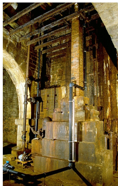
Massif de maçonnerie supportant les installations de pompage. A gauche, les anciennes canalisations de remontée de l'eau salée (hors d'usage). Phot. Yves Sancey IVR43_19973902025ZA
