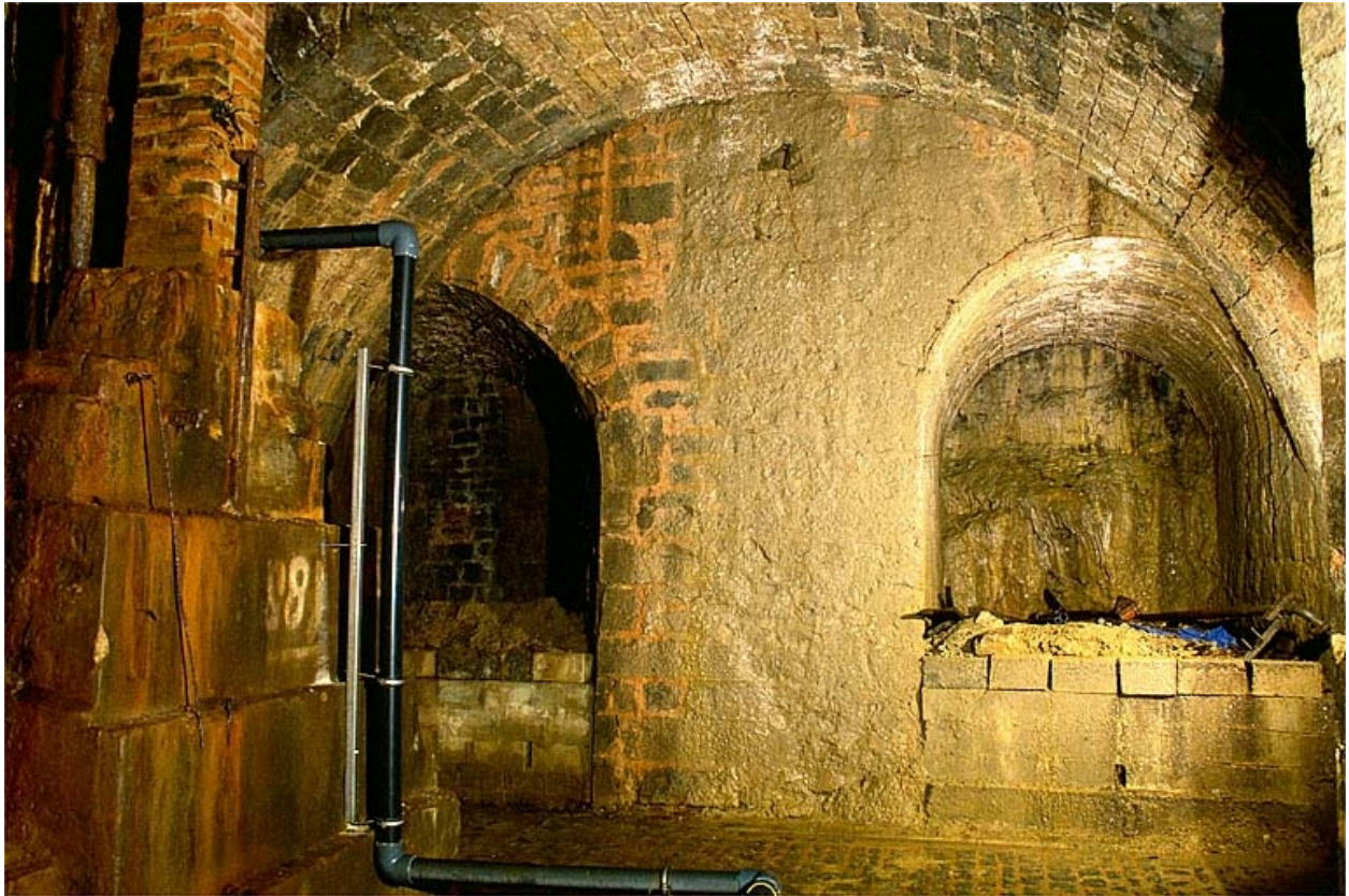
Mur nord du puits. La niche de gauche, comblée, donnait accès à une source salée.
