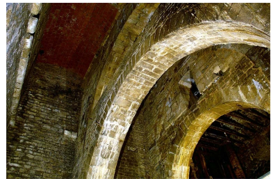
Arcs-diaphragmes et voûtement du puits. Phot. Yves Sancey IVR43_19973902030ZA
