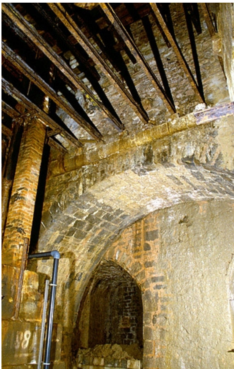
Angle nord-ouest du puits en contre-plongée.
