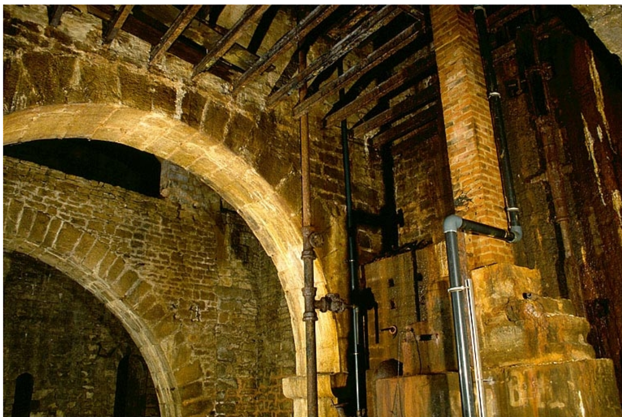
Parties supérieures du puits à Muire.
