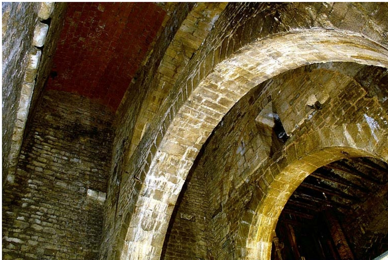
Arcs-diaphragmes et voûtement du puits.
